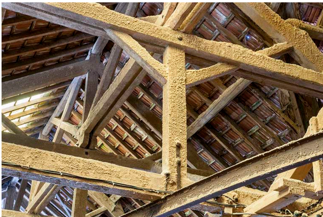
Détail de la charpente de l'atelier.
