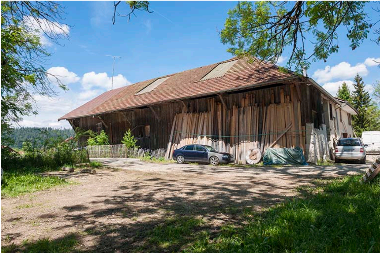
Atelier de scierie vu depuis le sud-est.
