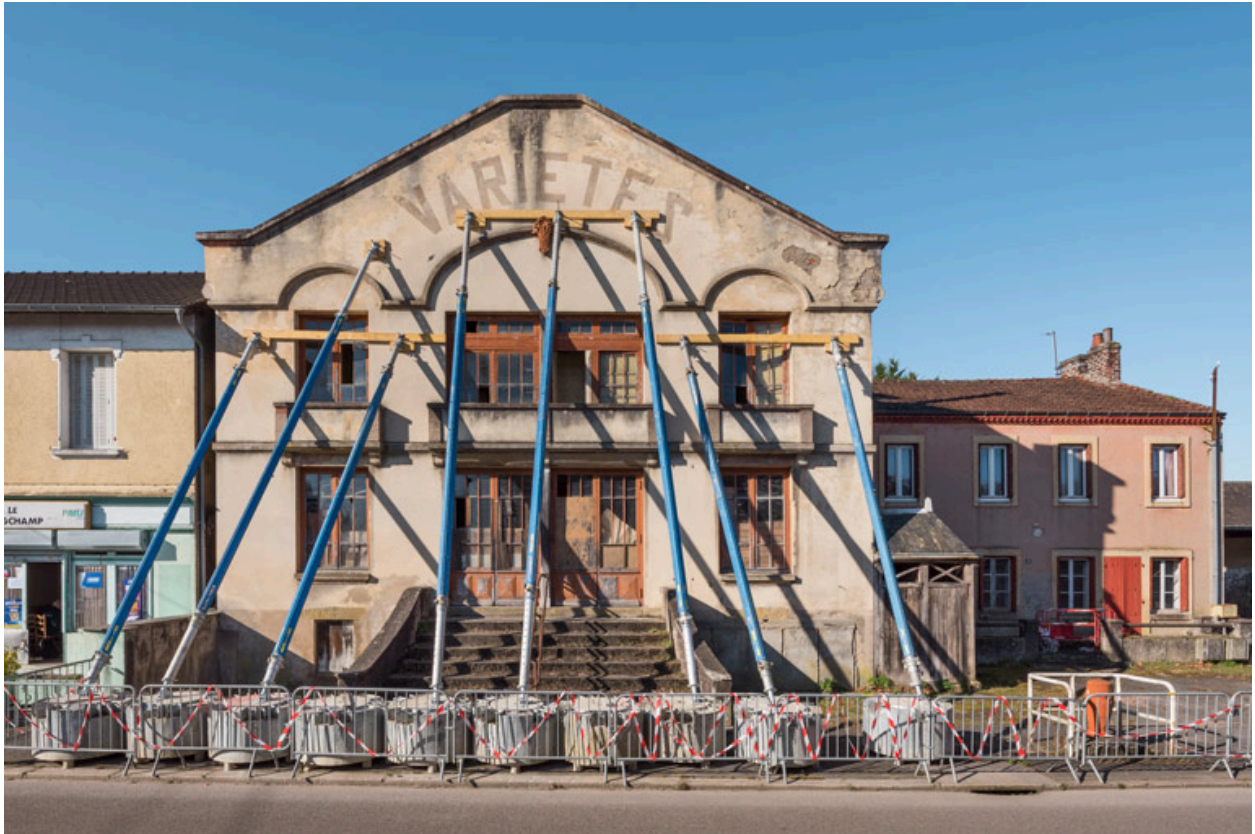
Façade antérieure. A droite la maison (ancien magasin de commerce de Marie Jault).
