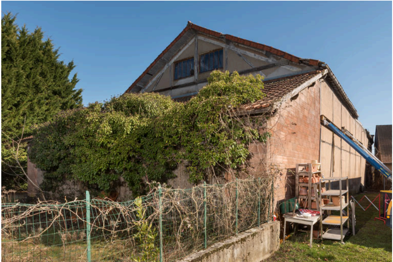
Extrémité occidentale du cinéma et corps en appentis.
