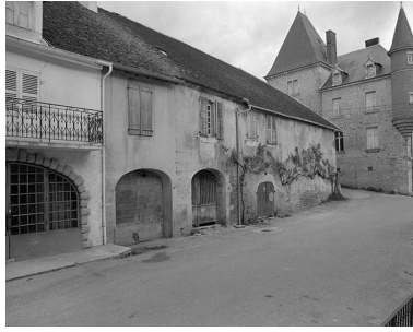
Façade sur la Grande Rue. Phot. Yves Sancey IVR43_19813900142X
