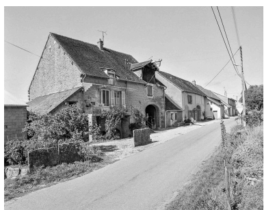
Fermes situées route Principale. Phot. Yves Sancey IVR43_19843900315X
