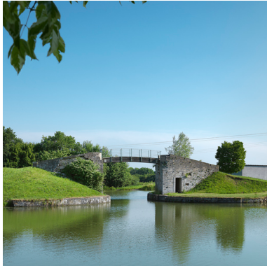
Vue de la passerelle haute, de face.
