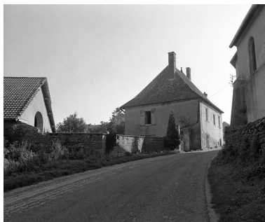
Presbytère. Phot. Yves Sancey IVR43_19802501186X
