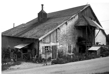
Ferme située 5 rue du chalet. Phot. Gilbert Poinot IVR43_19762500814Z
