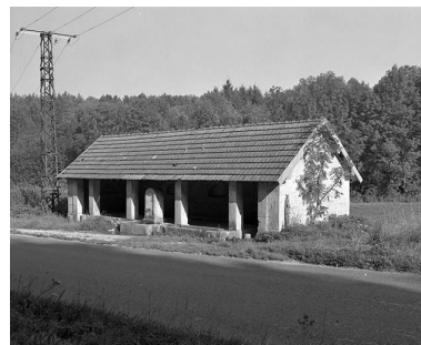
Fontaine-lavoir située rue de l'Eglise. Phot. Yves Sancey IVR43_19802501183X
