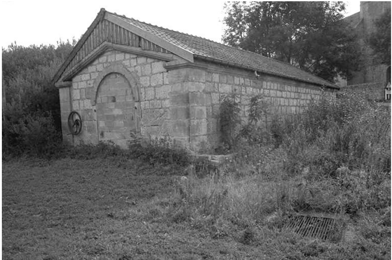
Fontaine, abreuvoir cadastrée 1972 AB 15 : vue générale.
