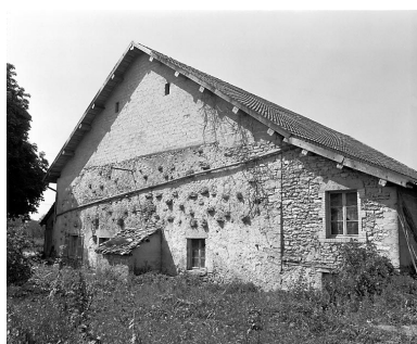
Ferme située rue du Chalet. Phot. Yves Sancey IVR43_19802501197X
