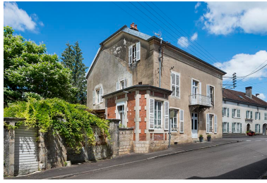
La demeure et le pavillon en brique. Phot. Jérôme Mongreville IVR43_20187000278NUC4A
