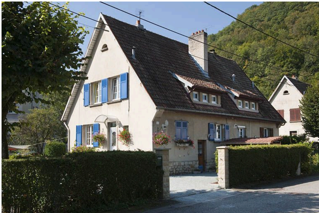
Maison jumelée. Pignon et façade nord.
