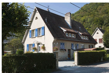
Maison jumelée. Pignon et façade nord. Phot. Jérôme Mongreville IVR43_20112502454NUC4A
