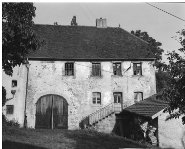
Ferme située rue du Petit Clos. Phot. Dominique Dominguez IVR43_19803900110X
