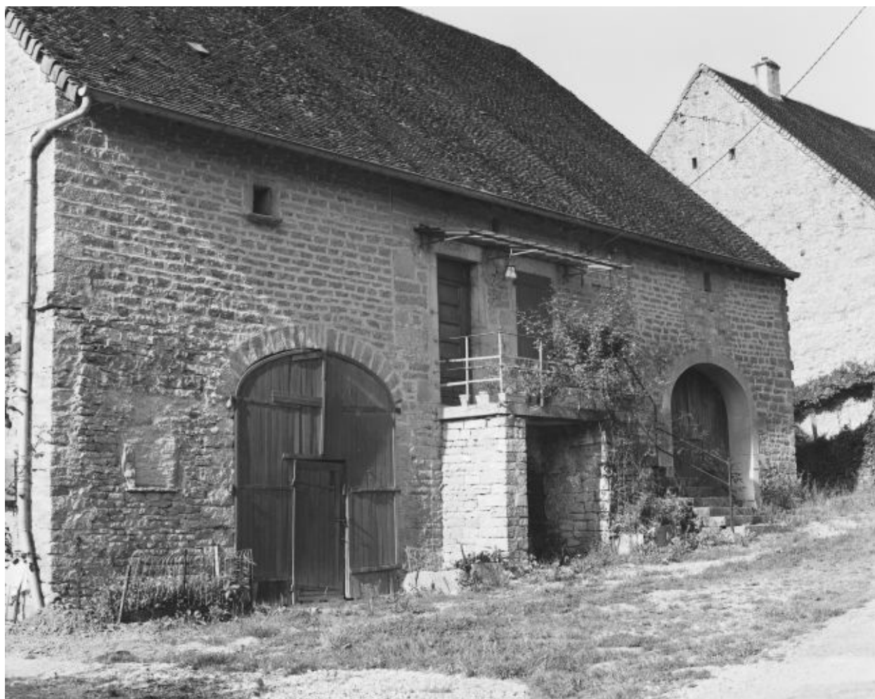
Ferme située rue du Bas du Village.
