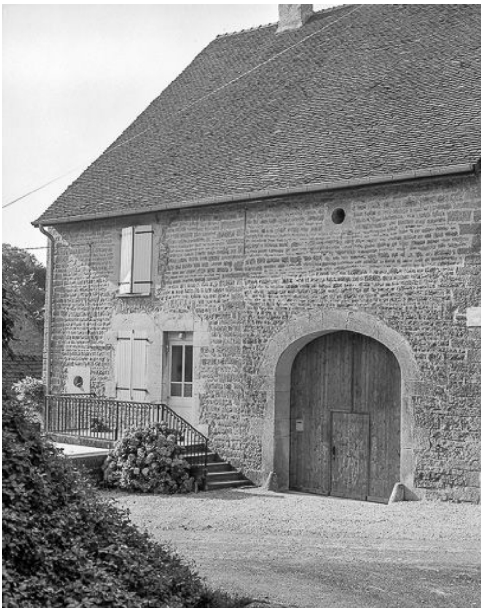
Ferme située rue du Bas du Village.
