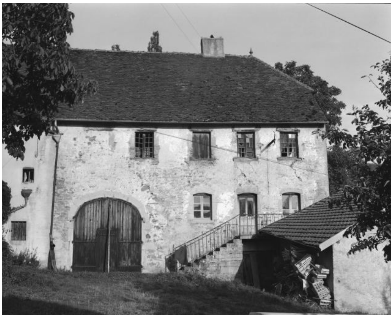
Ferme située rue du Petit Clos.
