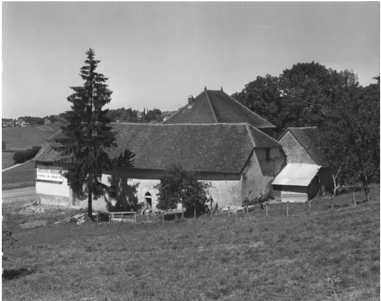
Relais de poste située au lieudit Mauffans.
