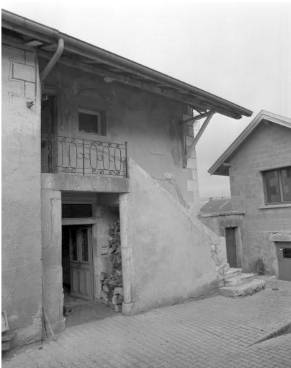
Partie droite de la façade antérieure.
