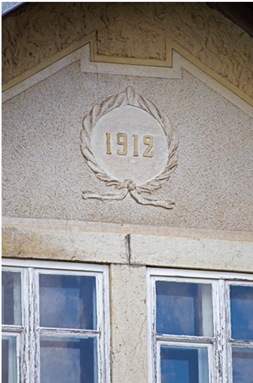
Façade latérale droite : date sur le pignon.
