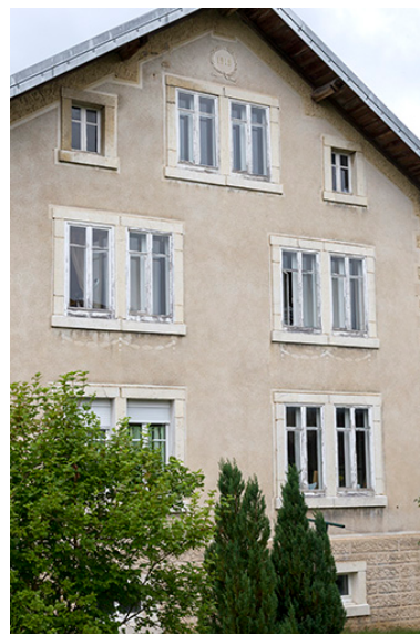
Façade latérale droite, de trois quarts gauche.
