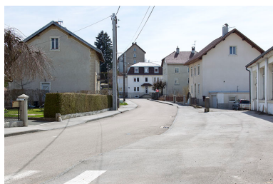
Vue d'ensemble de la rue Pasteur. La maison est visible à gauche.
