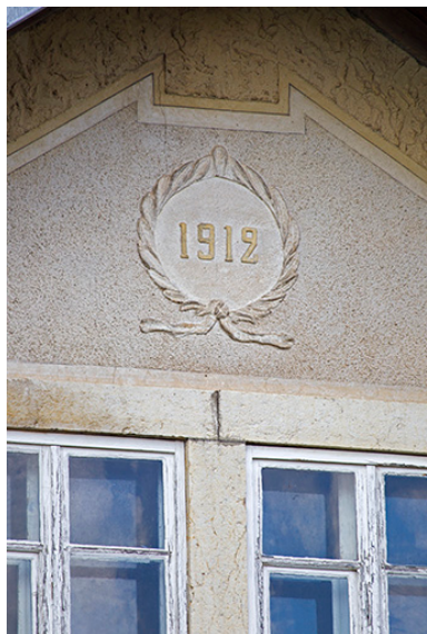
Façade latérale droite : date sur le pignon. Phot. Sonia Dourlot IVR43_20152500933NUC2A
