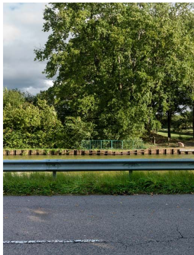
Vue de l'aqueduc. Phot. Pierre-Marie Barbe-Richaud IVR26_20177100284NUC2A
