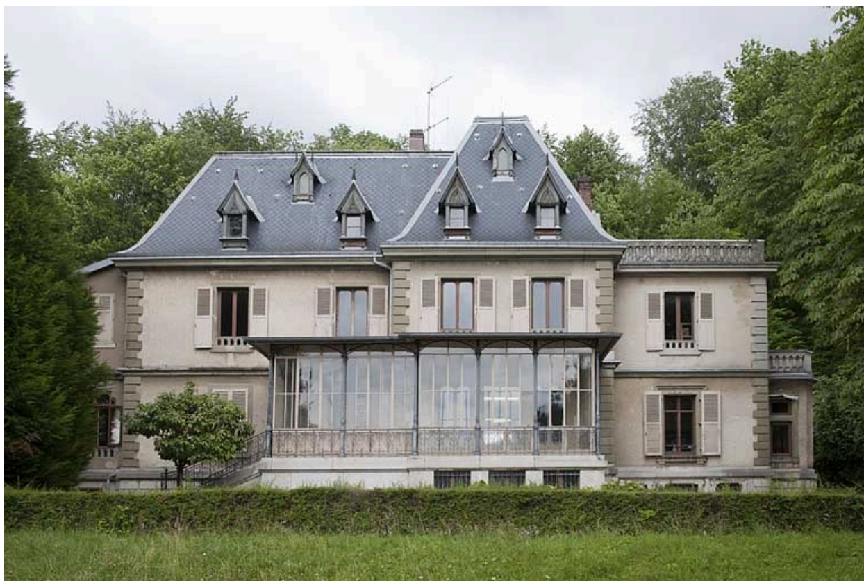
Façade antérieure depuis l'ouest.
