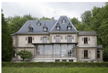
Façade antérieure depuis l'ouest. Phot. Jérôme Mongreville IVR43_20112501580NUC4A
