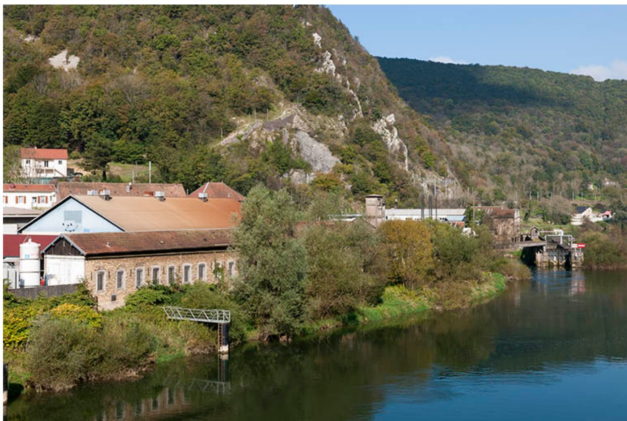
Vue rapprochée depuis le pont.
