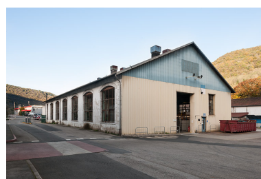
Atelier de forge vu de trois quarts. Phot. Jérôme Mongreville IVR43_20142501617NUC4A
