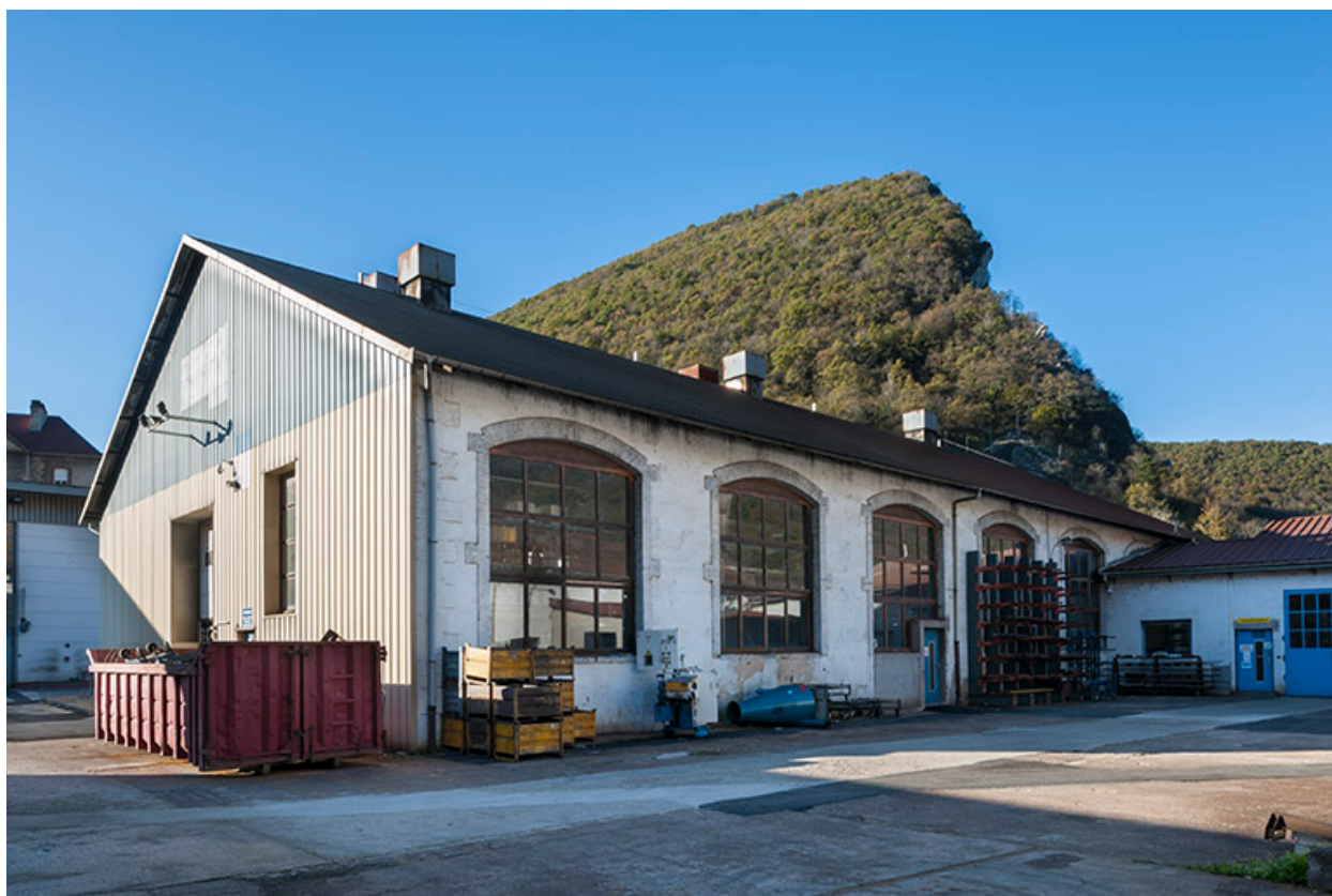
Atelier de forge, depuis la cour.
