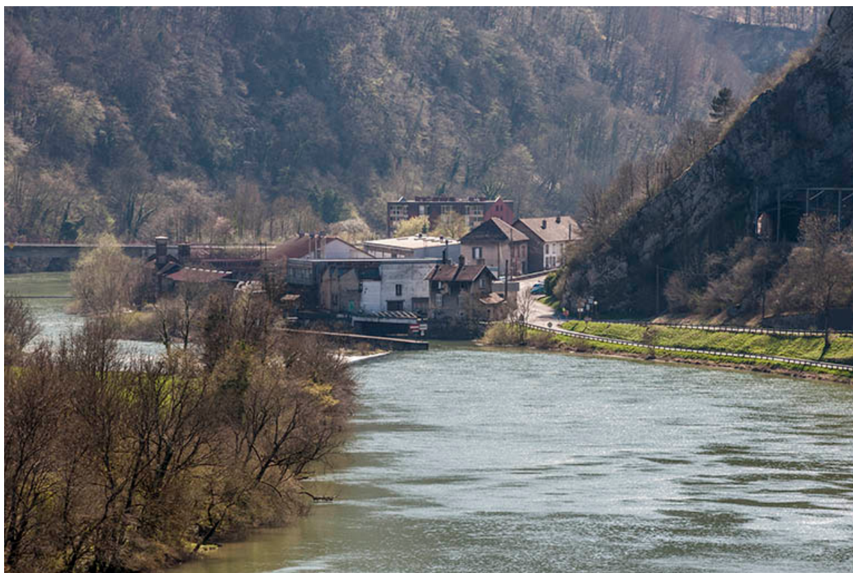
L'usine vue depuis l'amont.
