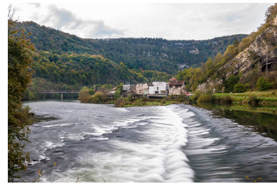
Vue d'ensemble depuis l'extrémité orientale du barrage. Phot. Jérôme Mongreville IVR43_20142501610NUC4A
