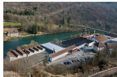
Vue plongeante depuis le nord-ouest. Phot. Jérôme Mongreville IVR43_20152500388NUC4A
