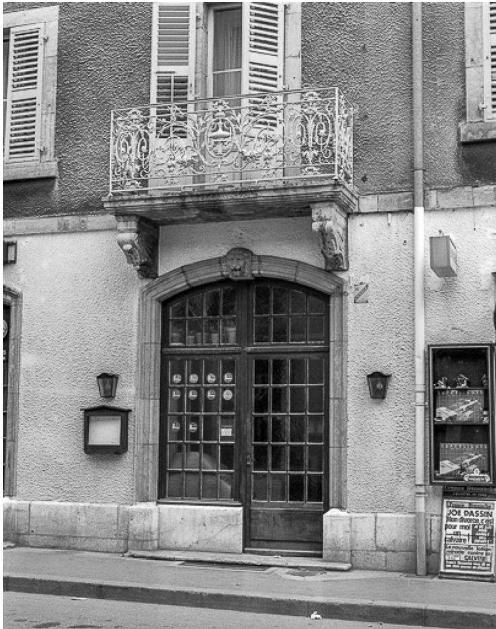
Porte d'entrée sur la rue de la Gare.
