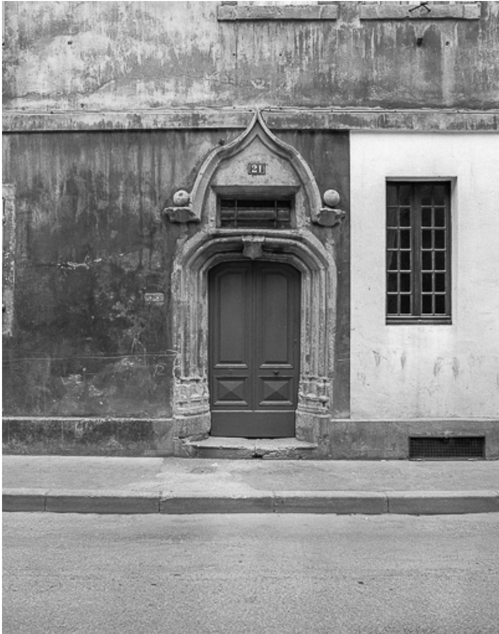
Détail : porte d'entrée sur la rue Gambetta, vue de face.
