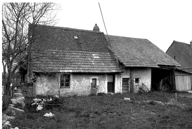
Vue d'ensemble. Phot. Bernard Lardière IVR43_19829000302Z
