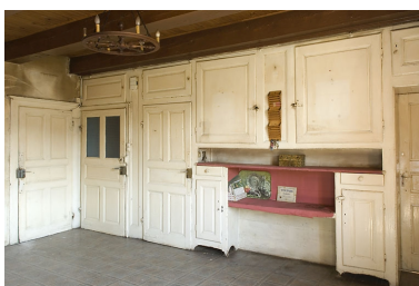
Cuisine du 2nd étage : portes et placards.
