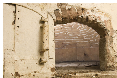
Cuisine du 1er étage : intérieur du four à pain. Phot. Jérôme Mongreville IVR43_20082500793NUC2A
