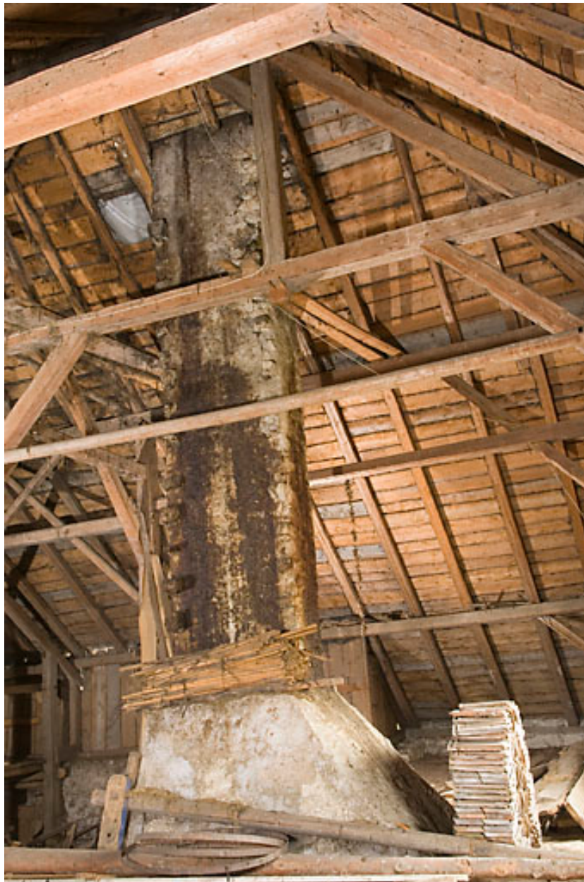
Grange : conduit de cheminée.
