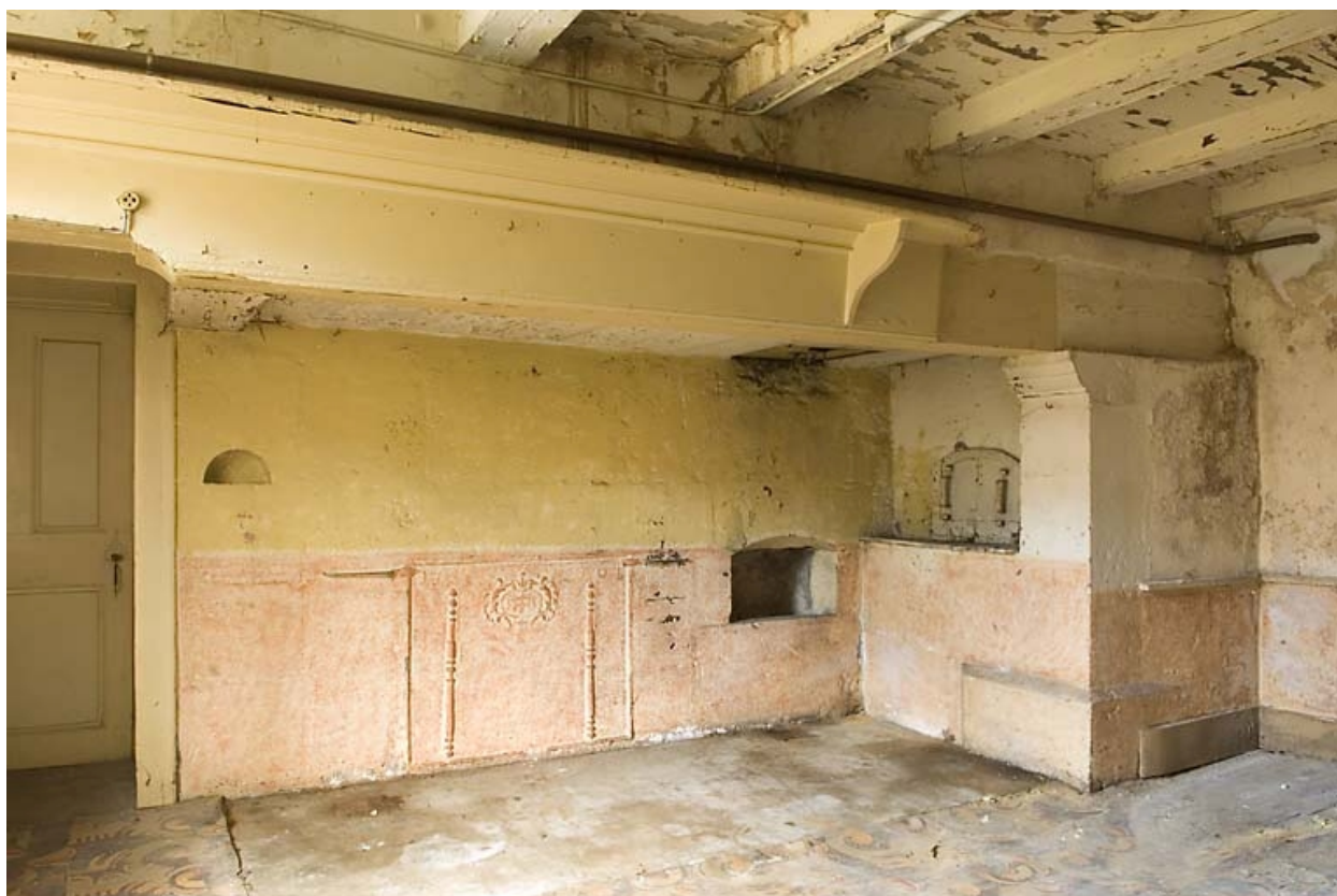
Cuisine du 1er étage : cheminée et four à pain.
