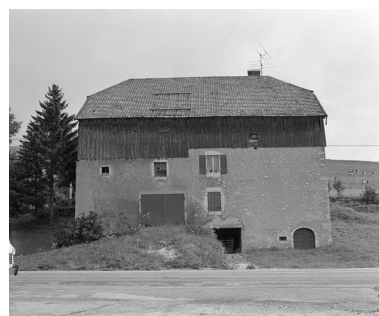
Façade postérieure (1978). Phot. Yves Sancey IVR43_19782500469X
