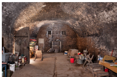
Intérieur de la cave. Phot. Jérôme Mongreville IVR43_20102501064NUC4A
