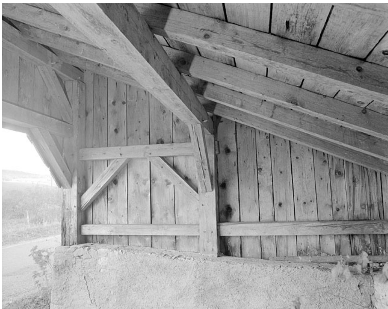
Détail de la charpente.
