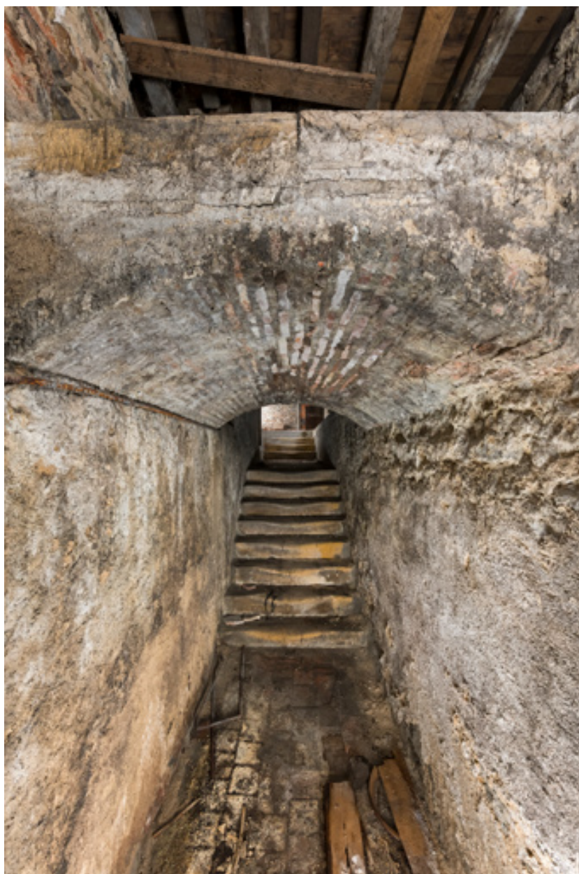
Couloir et escalier sous la salle.
