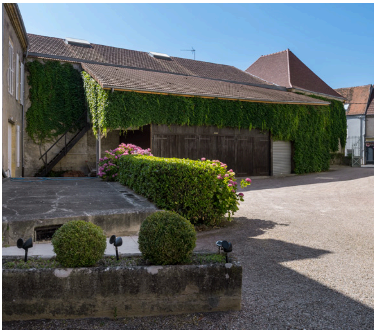
Façade latérale gauche, depuis une cour à l'est.
