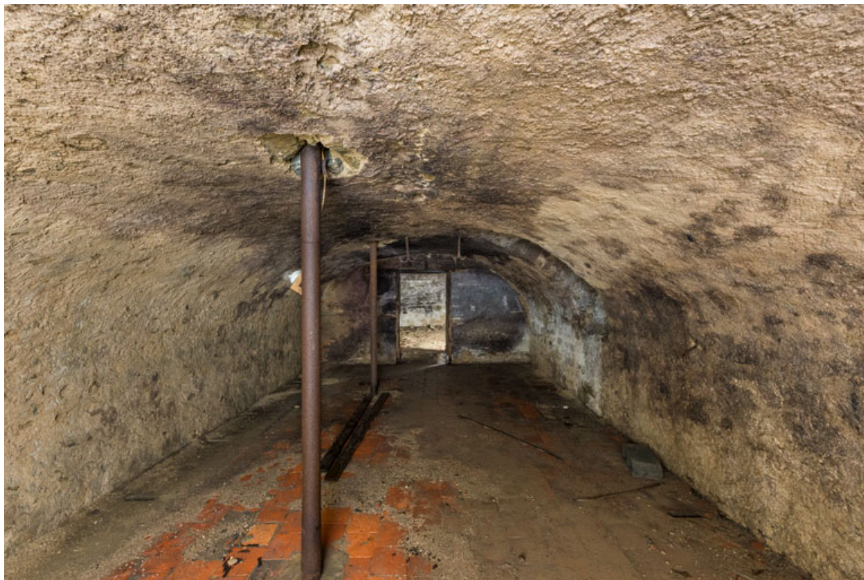
Cave voûtée sous la salle.
