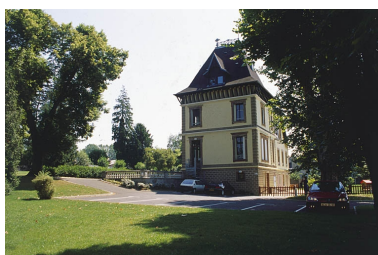
Le chalet Vermot depuis l'ouest. Phot. Yves Sancey IVR43_20009000557ZA
