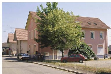
Logements ouvriers depuis l'avenue des Forges. Phot. Yves Sancey IVR43_20009000576ZA
