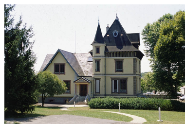
Façade antérieure du chalet Vermot. Phot. Yves Sancey IVR43_20009000563ZA
