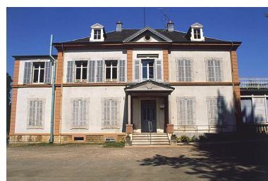
Façade est du logement patronal. Phot. Yves Sancey IVR43_20009000570ZA
