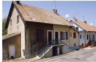
Logement ouvrier double. Phot. Yves Sancey IVR43_20009000597ZA
