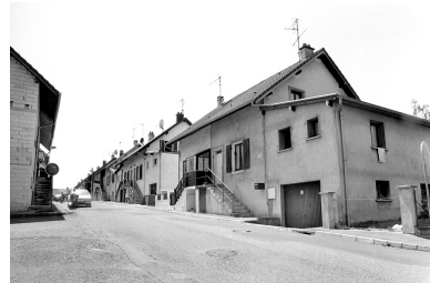
Logements ouvriers rue Antoine Marré. Phot. Yves Sancey IVR43_20009000604X
