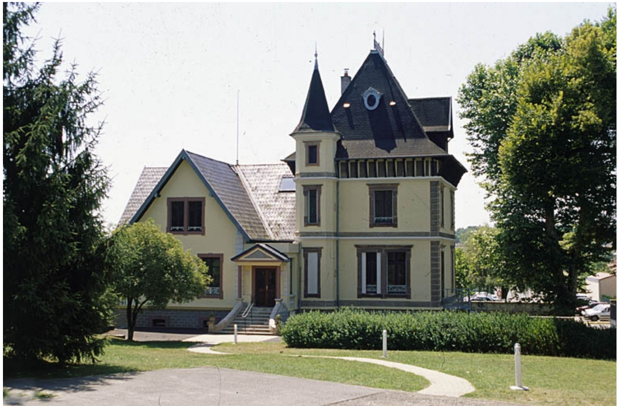
Façade antérieure du chalet Vermot.
