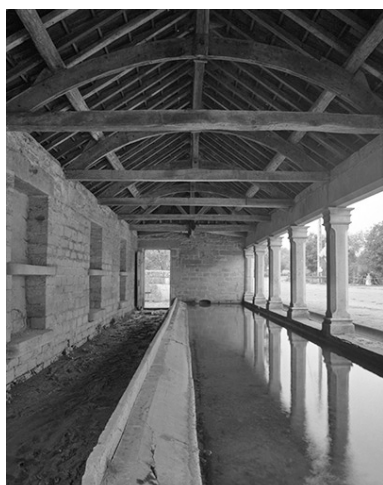
Détail : intérieur du lavoir. Phot. Yves Sancey IVR43_19857000038X
