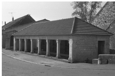
Vue d'ensemble. Phot. Bernard Lardière IVR43_19817000580Z
