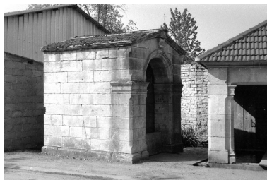
Détail : la fontaine. Phot. Bernard Lardière IVR43_19817000581Z
