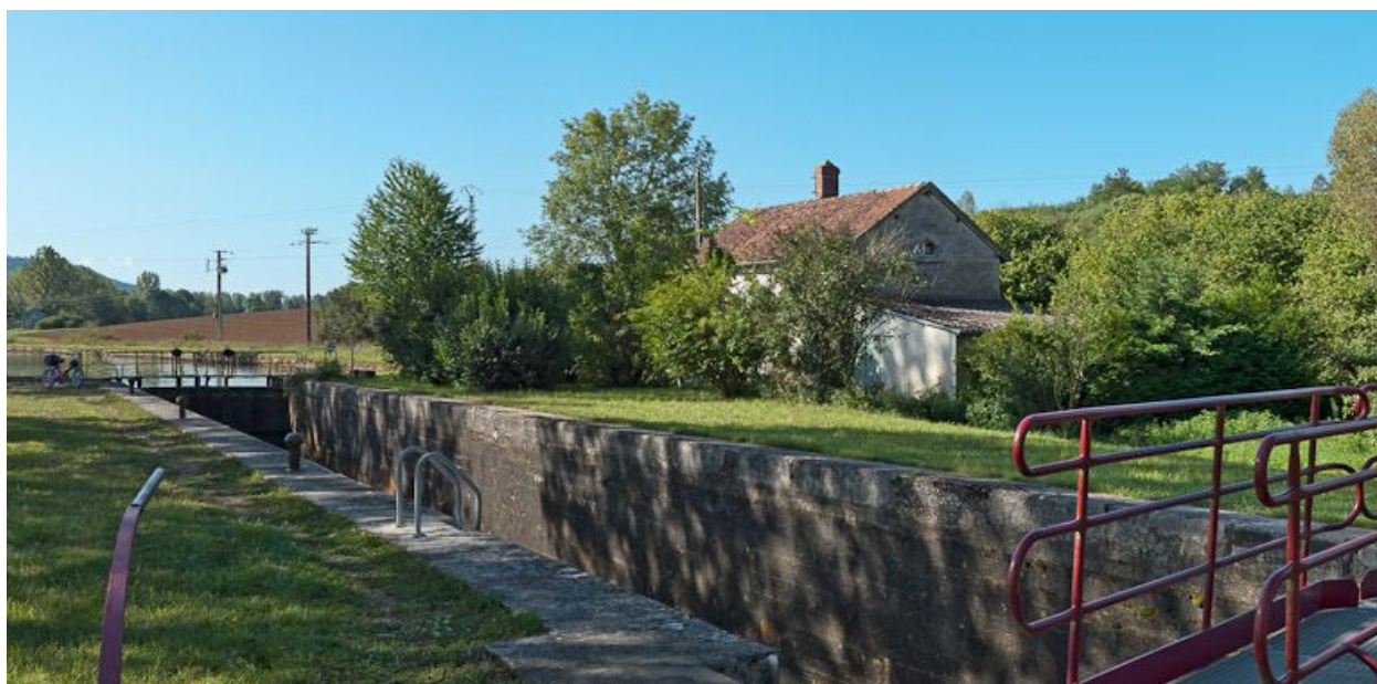
Vue d'ensemble du site d'écluse.
