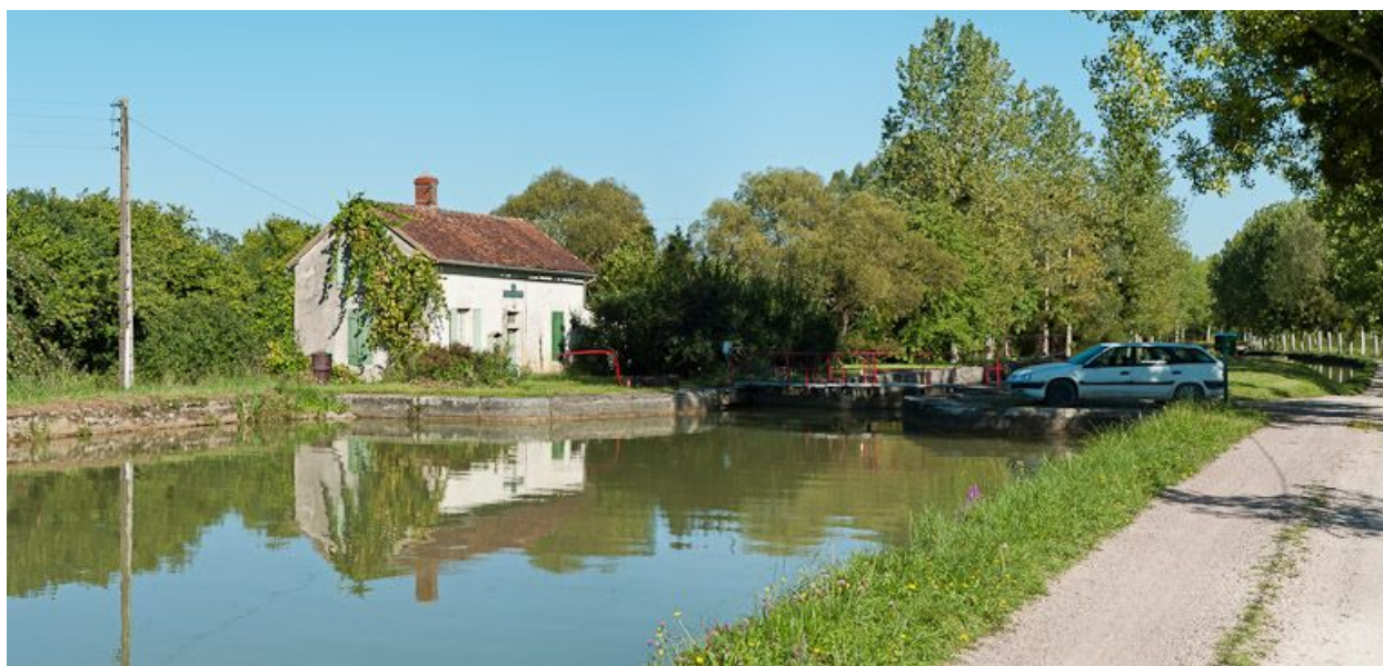
Vue du site d'écluse depuis l'amont.
