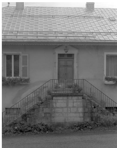
L'escalier menant au logis. Phot. Jérôme Mongreville IVR43_19943901274X
