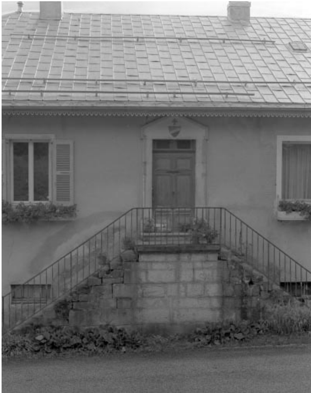
L'escalier menant au logis.
