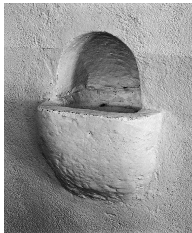
Niche du mur droit. Phot. Michel Rosso IVR26_19792100096X
