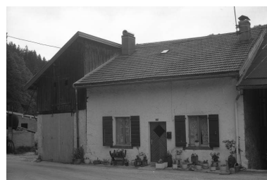
Ancien logement d'ouvriers. Phot. Laurent Poupard IVR43_19913901532Z
