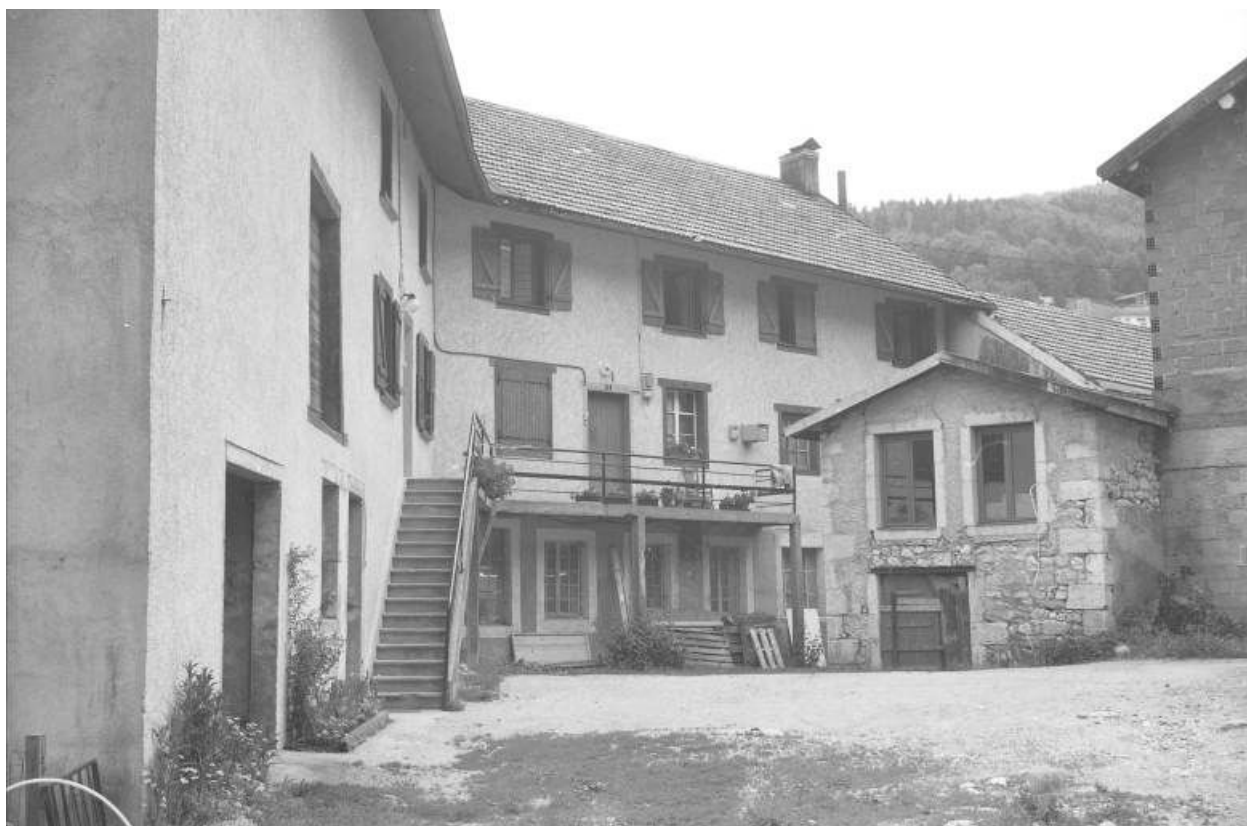
Ancienne clouterie : façades sur la cour.
