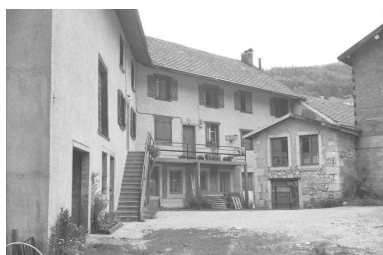
Ancienne clouterie : façades sur la cour. Phot. Laurent Poupard IVR43_19913901527Z
