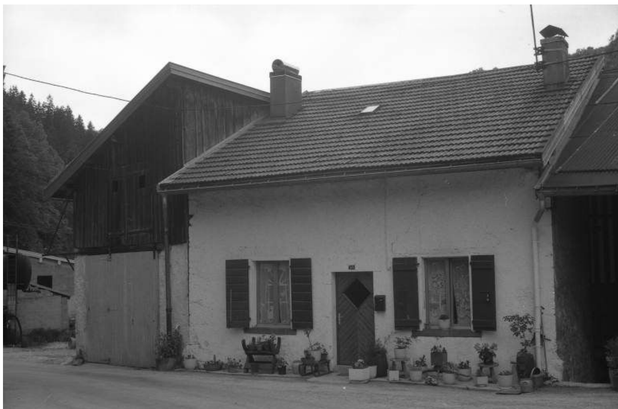
Ancien logement d'ouvriers.
