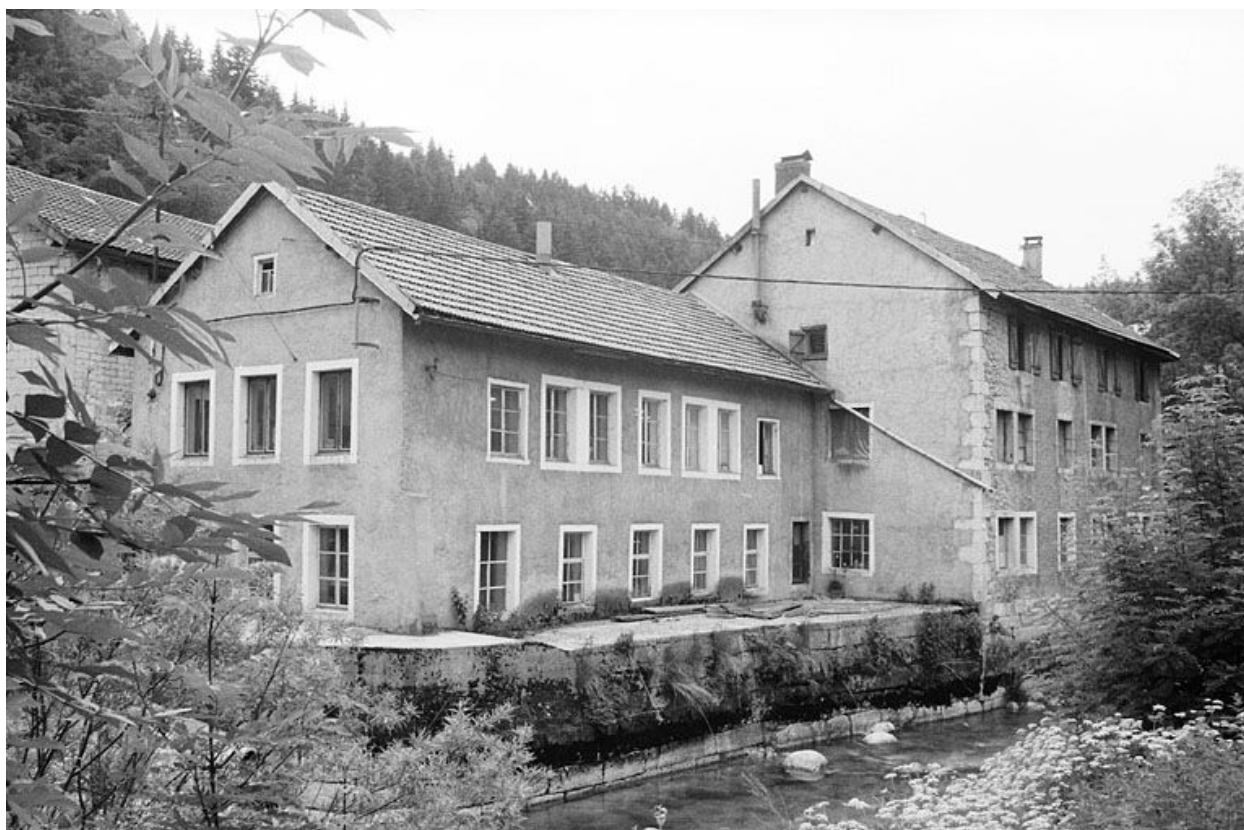
Ancienne clouterie : façades sur la Bienne.
