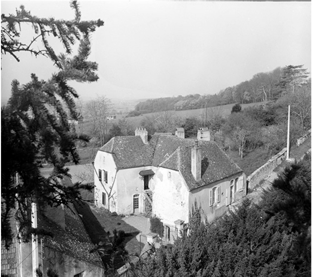
[Vue d'ensemble depuis le parc du château], 1955.
