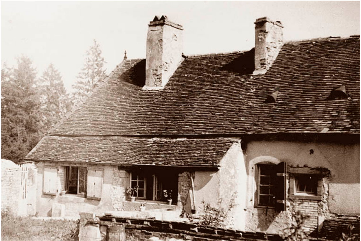
[Vue partielle des communs], 1955.
