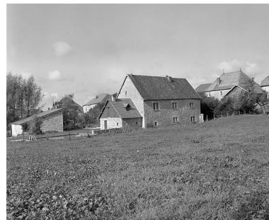
Façade postérieure vue depuis le pré. Phot. Yves Sancey IVR43_19802501042X
