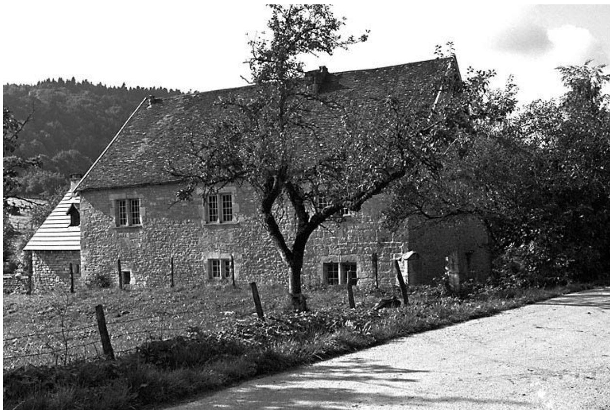
Façade postérieure vue depuis le chemin.
