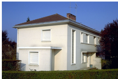
Façade antérieure et face droite.
