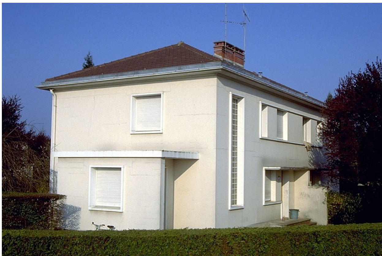
Façade antérieure et face droite.
