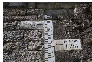
Partie supérieure de l'échelle limnimétrique, indiquant le niveau des crues de 1852 et 1896. Trois crues sont signalées : 10 mars 1896 (7,96 m), 18 septembre 1852 (8,50 m) et 21 janvier 1910 (9,57 m). La plaque de cette dernière manque. Phot. Yves Sancey IVR43_20062500174NUCA
