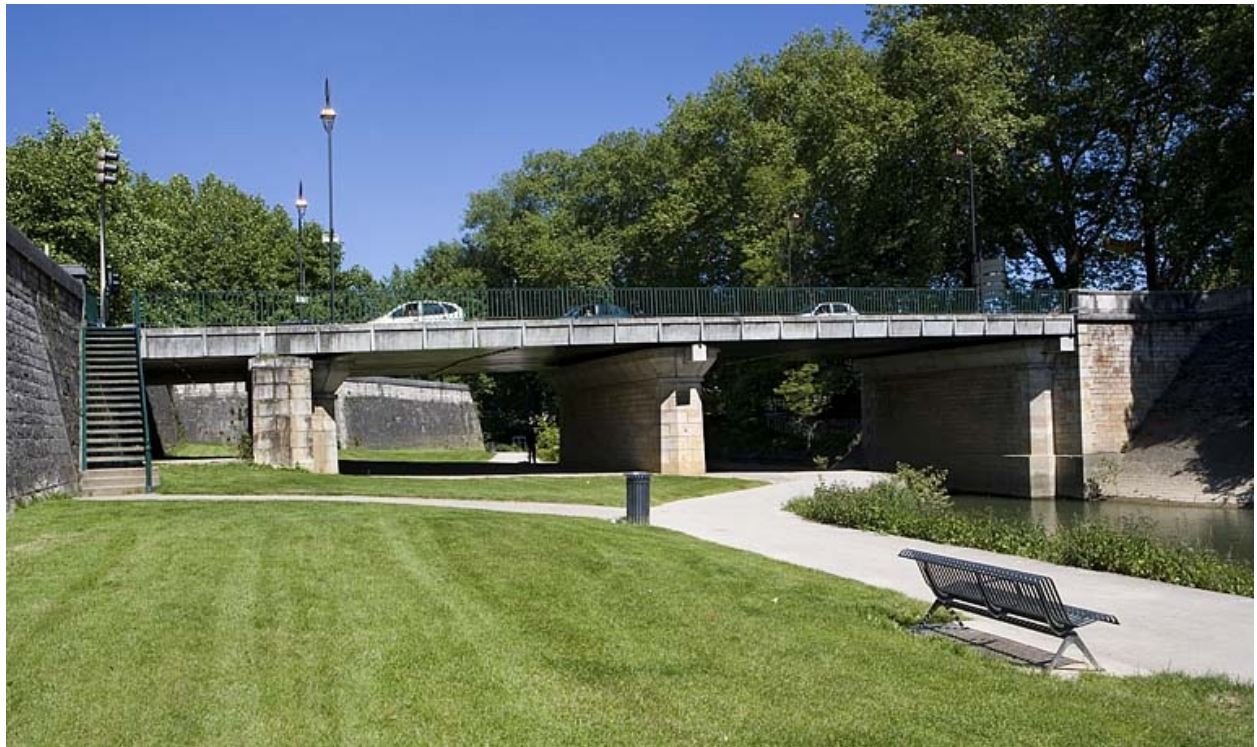
L'arche marinière du pont de la République.
