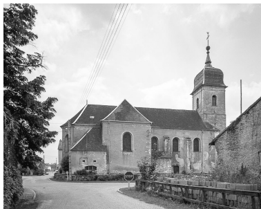
Extérieur : façade latérale gauche. Phot. Yves Sancey IVR43_19837000108V
