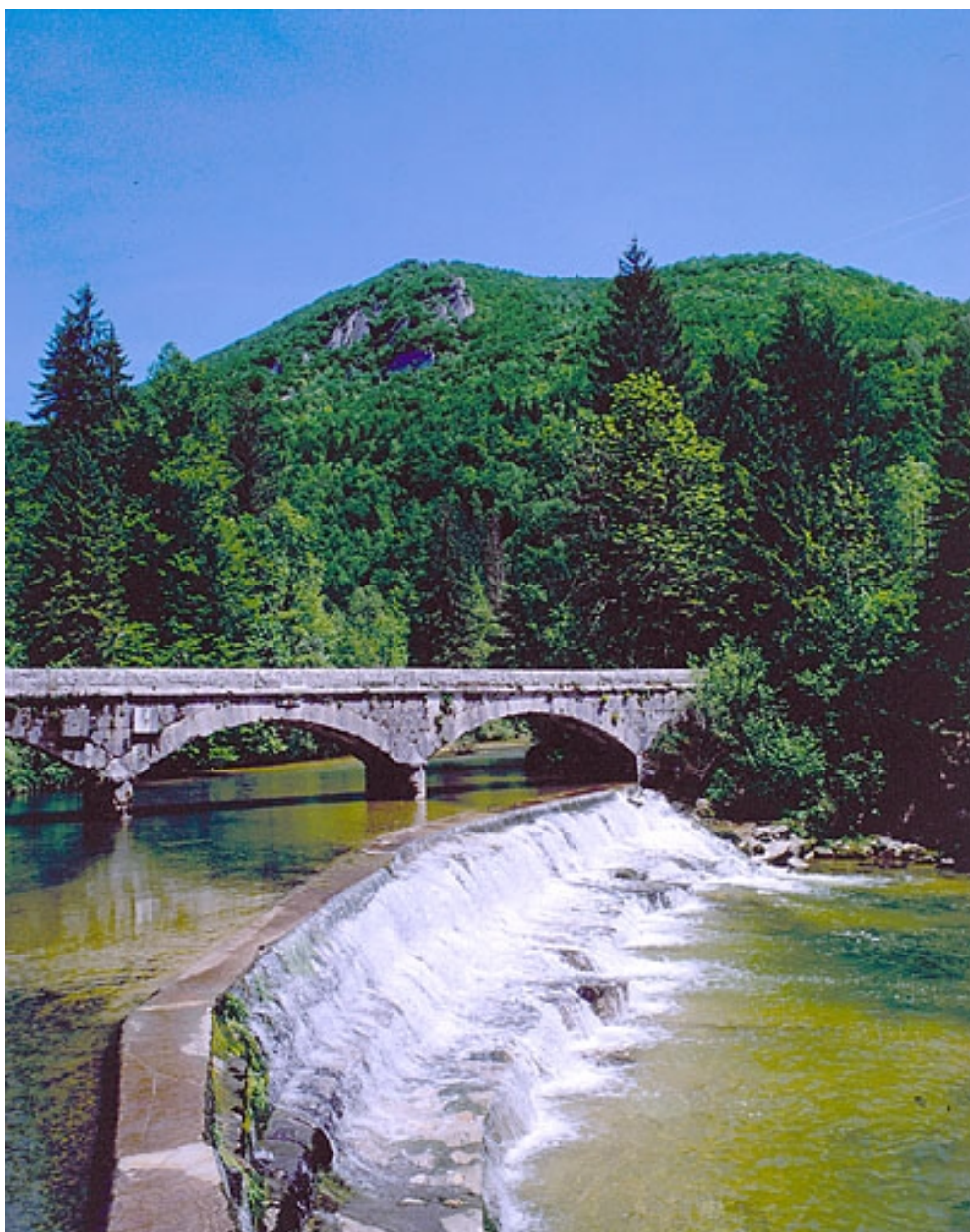
Partie droite depuis l'aval.
