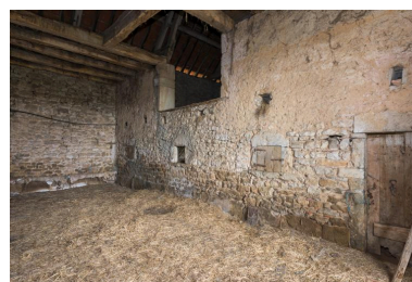
Remise à chars Phot. Pierre-Marie Barbe-Richaud IVR26_20187100246NUC4A
