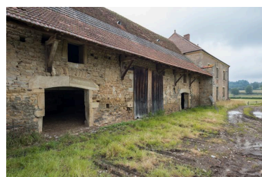
Vue de la grange avec son large débord de toit Phot. Pierre-Marie Barbe-Richaud IVR26_20187100243NUC4A
