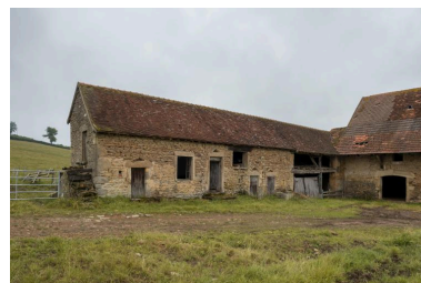
Vue du bâtiment de dépendance secondaire abritant notamment les soues à cochons et le fournil Phot. Pierre-Marie Barbe-Richaud IVR26_20187100234NUC4A
