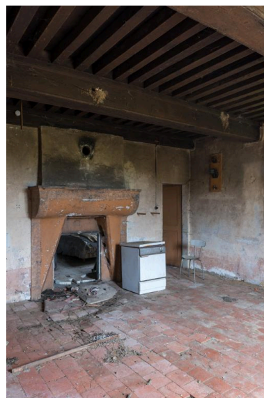
Ancienne cuisine, ornée d'une cheminée avec un double foyer à l'origine divisé par un plaque de fonte, l'un donnant dans la pièce principale, l'autre dans la pièce secondaire voisine. Phot. Pierre-Marie Barbe-Richaud IVR26_20187100250NUC4A
