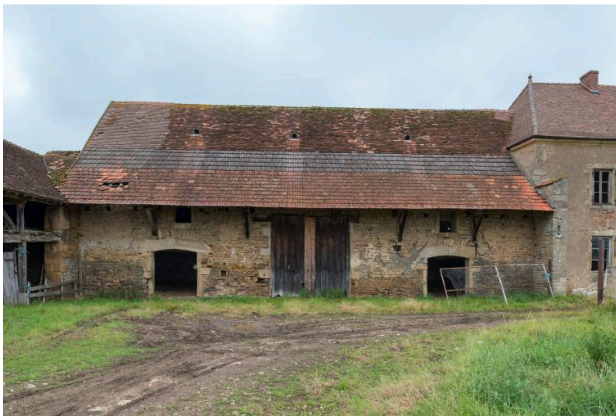
Façade antérieure de la grange
