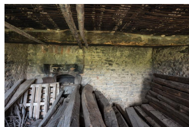
Intérieur du fournil Phot. Pierre-Marie Barbe-Richaud IVR26_20187100239NUC4A
