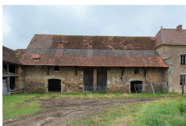
Façade antérieure de la grange Phot. Pierre-Marie Barbe-Richaud IVR26_20187100242NUC4A
