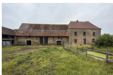
Façade antérieure des bâtiments principaux : grange et maison Phot. Pierre-Marie Barbe-Richaud IVR26_20187100241NUC4A
