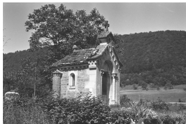
Vue générale. Phot. Guy Forestier IVR43_19743900598Z
