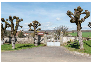
Grille d'entrée et mur d'enceinte du cimetière. Phot. Sonia Dourlot IVR43_20177000305NUC4A
