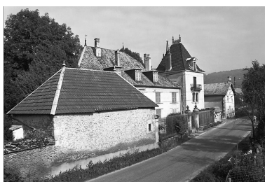
Demeure située rue du Général Broissia. Phot. Yves Sancey IVR43_19802501169X
