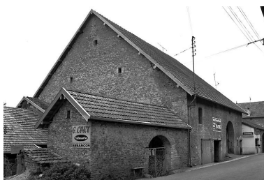
Ferme située rue du Miroir. Phot. Yves Sancey IVR43_19802501142X
