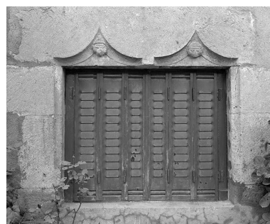
Maison située à Maisières-Notre- Dame, cadastrée 1971 AB 23 : linteau de baie orné de têtes humaines. Phot. Yves Sancey IVR43_19802501175X
