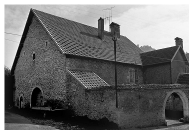
Presbytère. Phot. Yves Sancey IVR43_19802501148X
