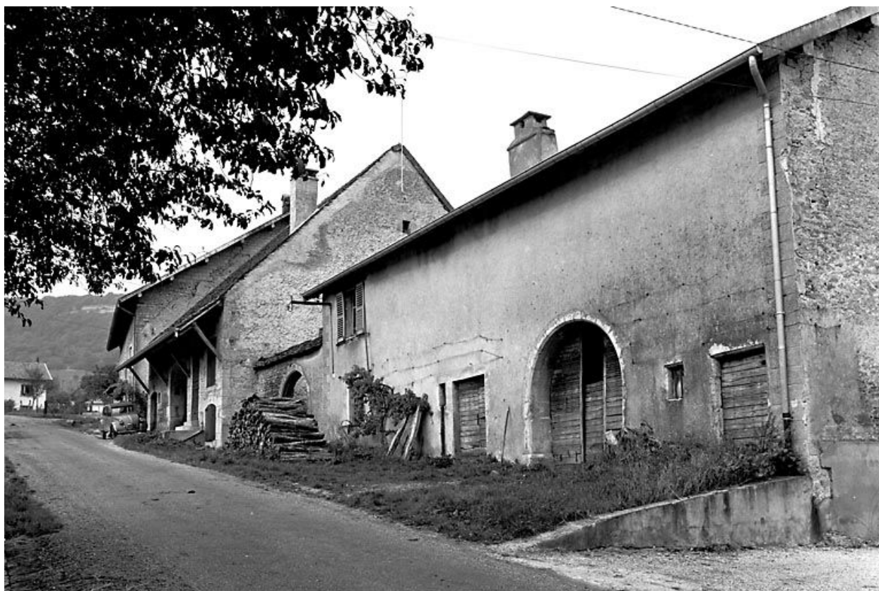
Ferme située rue de la Fontaine.
