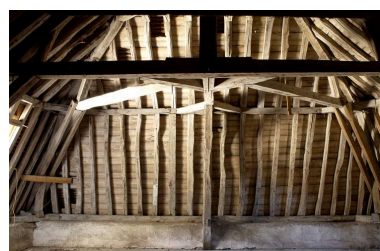
Aile droite : charpente, croupe sur la salle Sainte-Marthe. Phot. Michel Thierry IVR26_20042100561NUC2A
