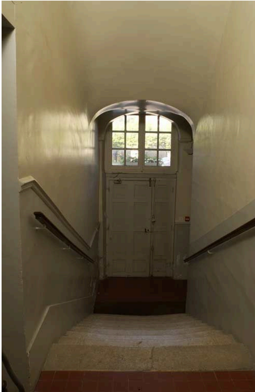
Ancien hôtel du gouverneur : escalier rampe sur rampe, 2e volée entre le rez-de-chaussée surélevé et la porte d'entrée principale.
