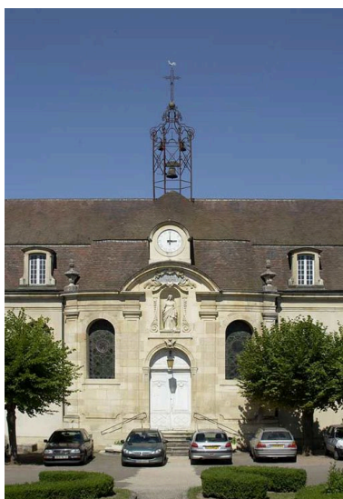
Aile droite : élévation sur la cour antérieure, travée de la chapelle. Phot. Michel Thierry IVR26_20042100522NUC2A
