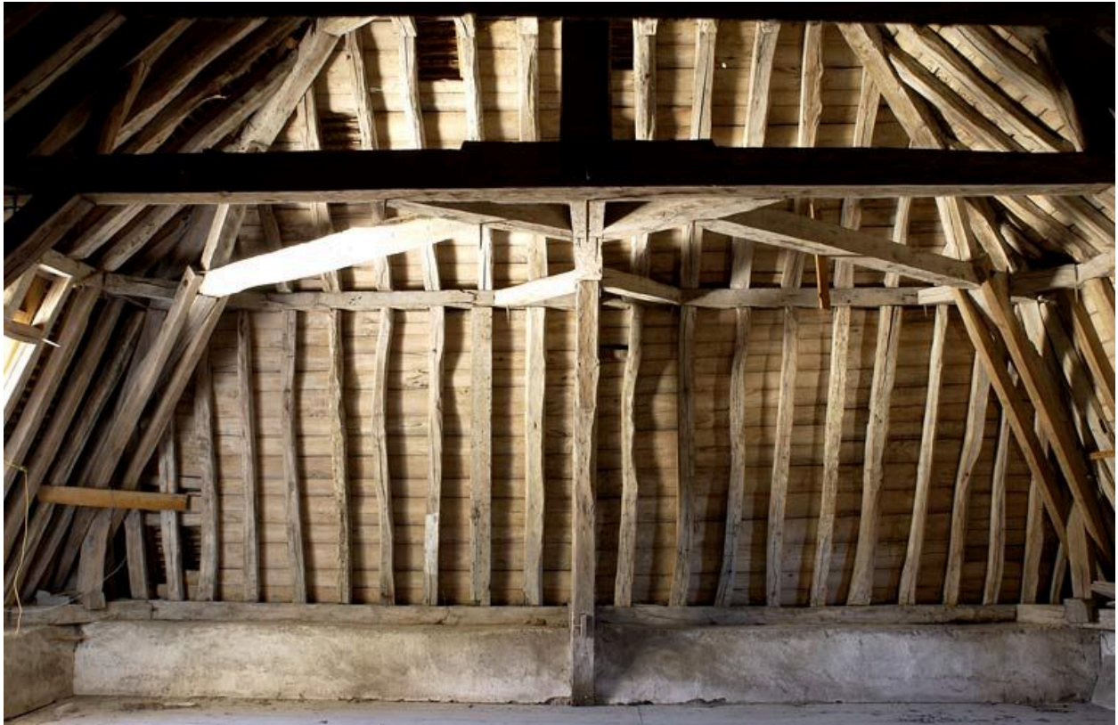
Aile droite : charpente, croupe sur la salle Sainte-Marthe.
