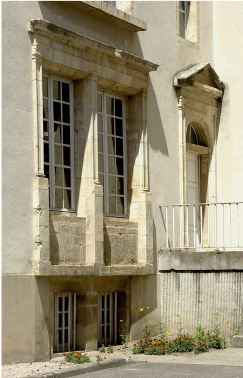
Ancien hôtel du gouverneur : élévation postérieure, fenêtres du salon précédant la pharmacie.
