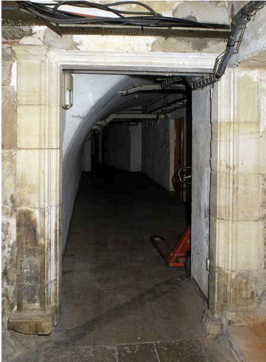
Ancien hôtel du gouverneur : sous-sol, porte.
