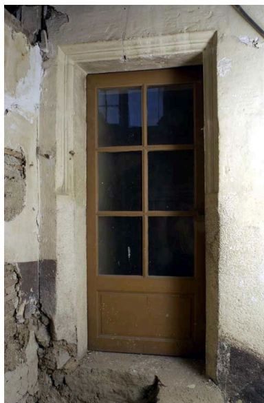
Ancien hôtel du gouverneur : fenêtre transformée en porte au fond du passage donnant accès au laboratoire. Phot. Michel Thierry IVR26_20042100597NUC2A
