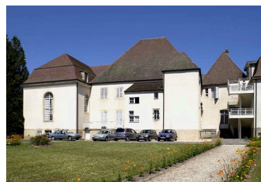
Ancien hôtel du gouverneur (élévation postérieure) et élévation gauche de l'ancienne salle des femmes, salle Sainte-Marthe. Phot. Michel Thierry IVR26_20042100531NUC2A
