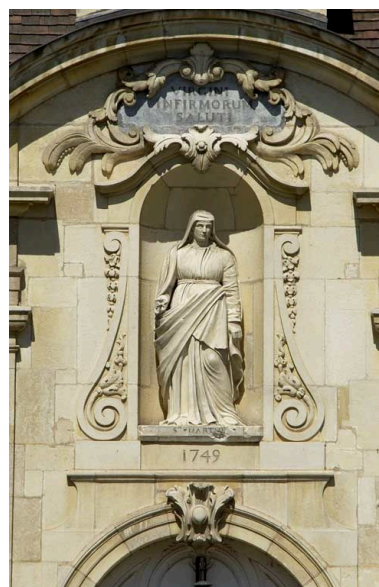
Aile droite : travée de la chapelle, niche et statue de sainte Marthe. Phot. Michel Thierry IVR26_20042100524NUC2A
