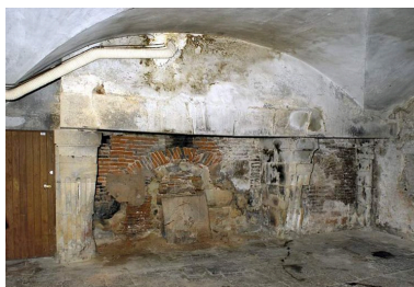
Ancien hôtel du gouverneur : sous-sol, cheminée. Phot. Michel Thierry IVR26_20042100723NUC2A
