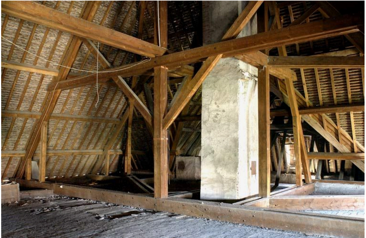
Aile droite : charpente.
