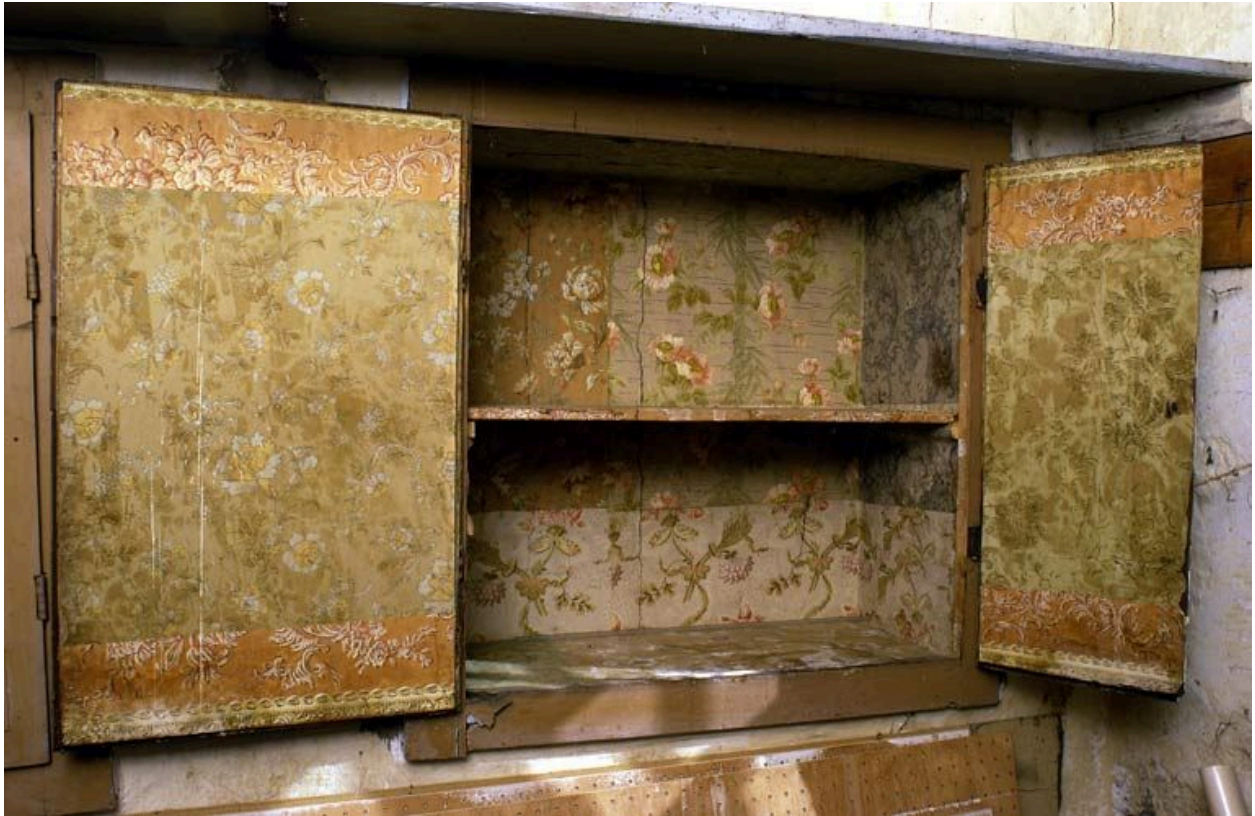
Ancien hôtel du gouverneur : pièce dite laboratoire, détail : intérieur du deuxième placard mural gauche.
