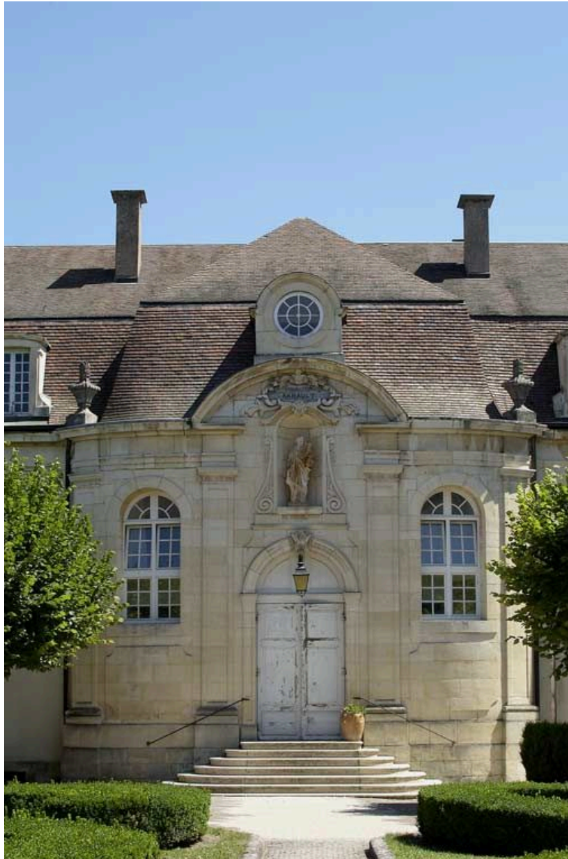
Aile gauche dite fondation Arnault : élévation sur la cour antérieure, avant-corps central.
