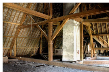
Aile droite : charpente. Phot. Michel Thierry IVR26_20042100558NUC2A
