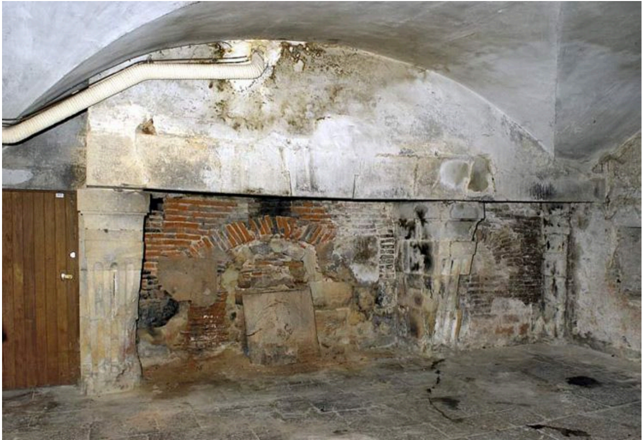
Ancien hôtel du gouverneur : sous-sol, cheminée.
