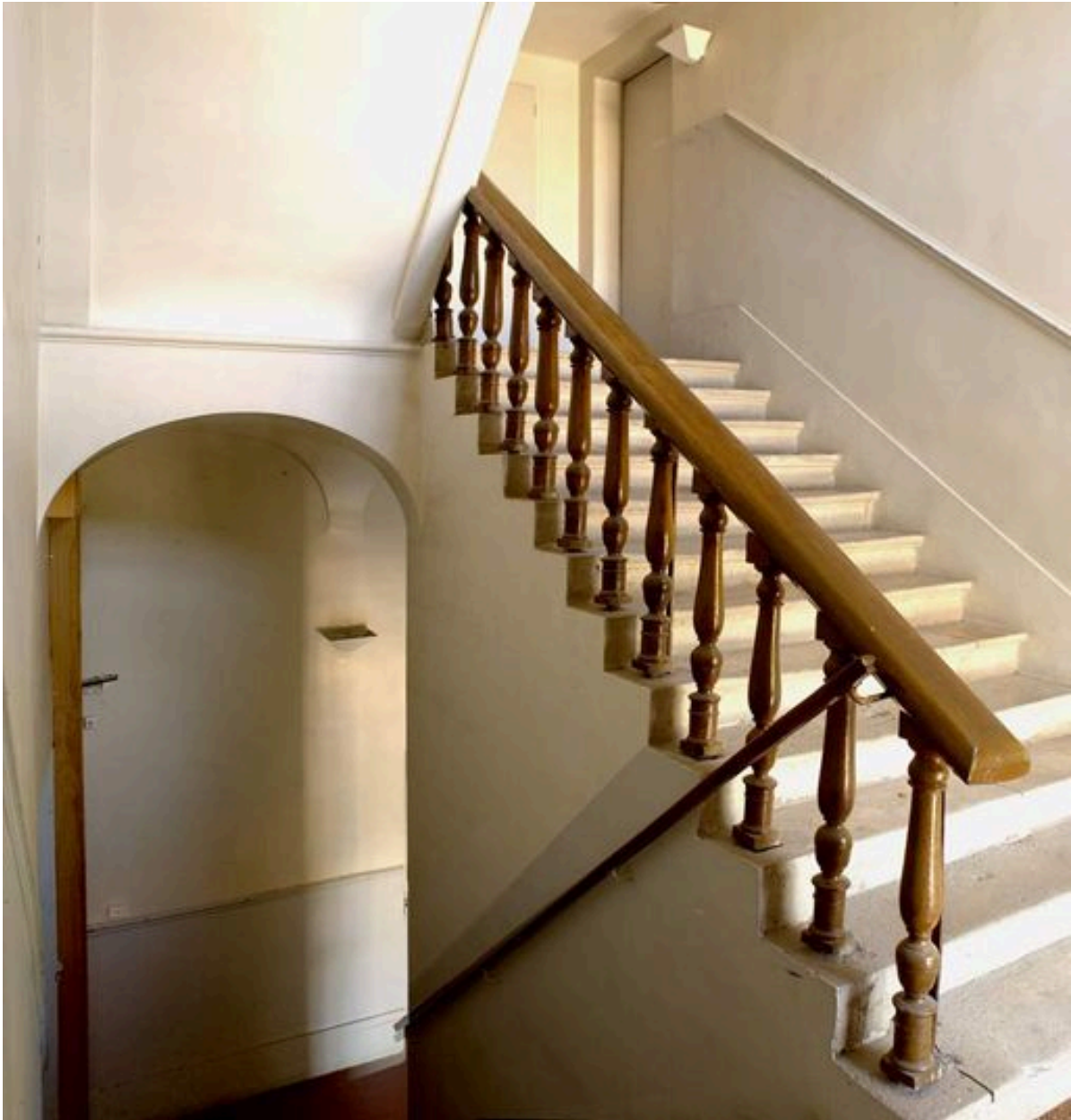
Ancien hôtel du gouverneur : escalier rampe sur rampe, 4e volée à rampe d'appui à balustres.
