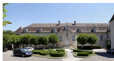
Aile gauche dite fondation Arnault : élévation sur la cour antérieure. Phot. Michel Thierry IVR26_20042100563NUC2A
