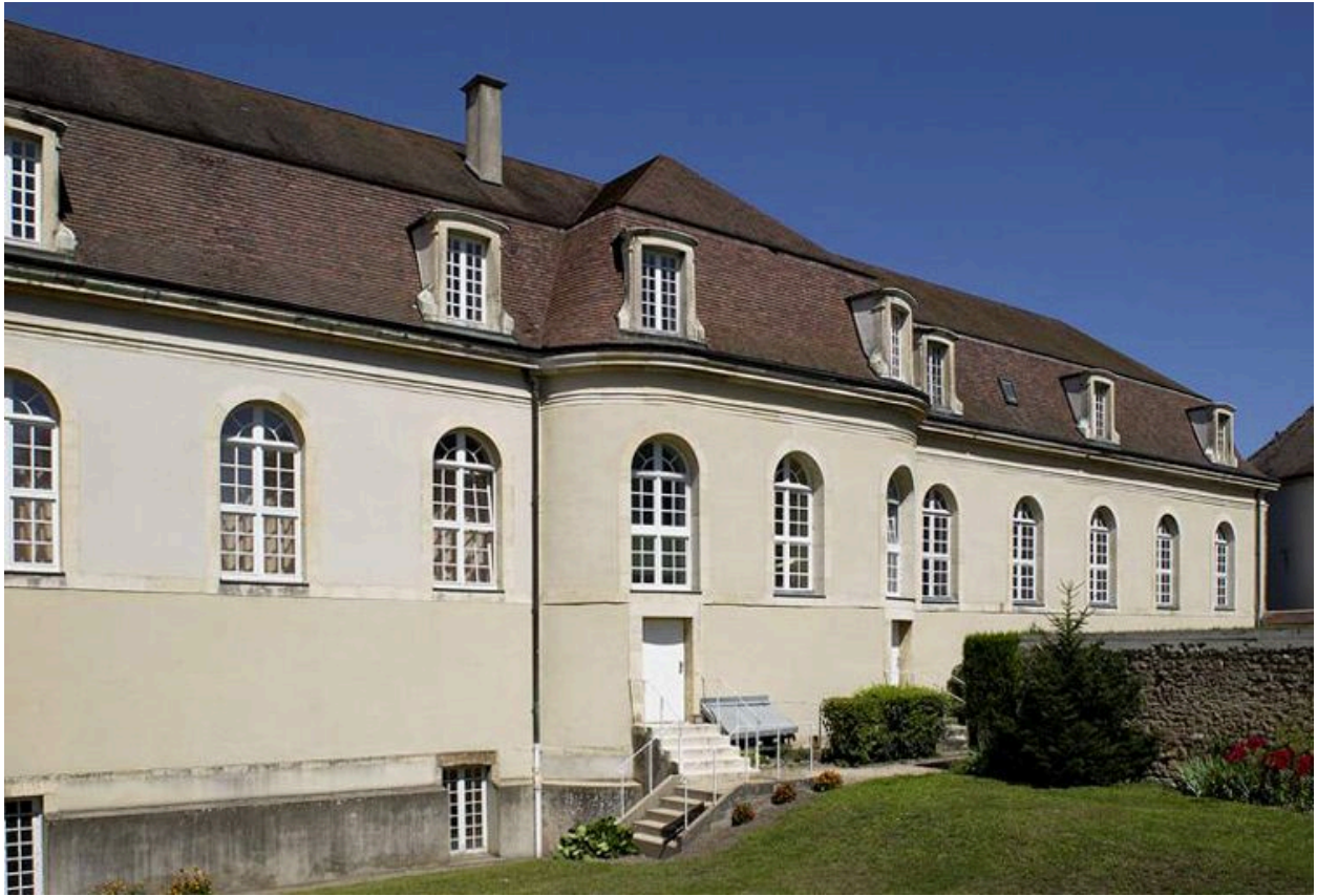
Aile gauche dite fondation Arnault : élévation postérieure.
