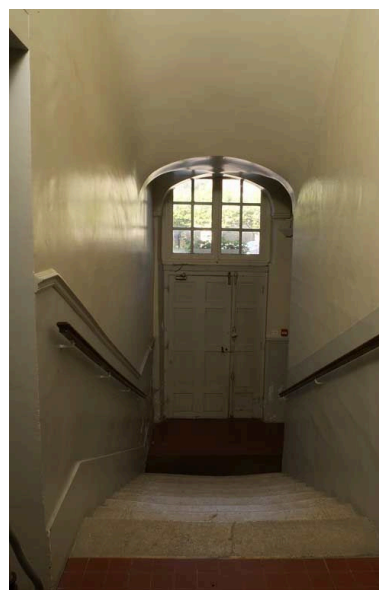
Ancien hôtel du gouverneur : escalier rampe sur rampe, 2e volée entre le rez-de-chaussée surélevé et la porte d'entrée principale. Phot. Michel Thierry IVR26_20042100601NUC2A
