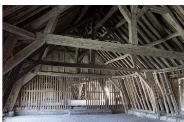
Aile droite : charpente. Phot. Michel Thierry IVR26_20042100560NUC2A
