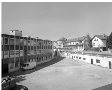
Vue plongeante sur la cour de l'usine.
