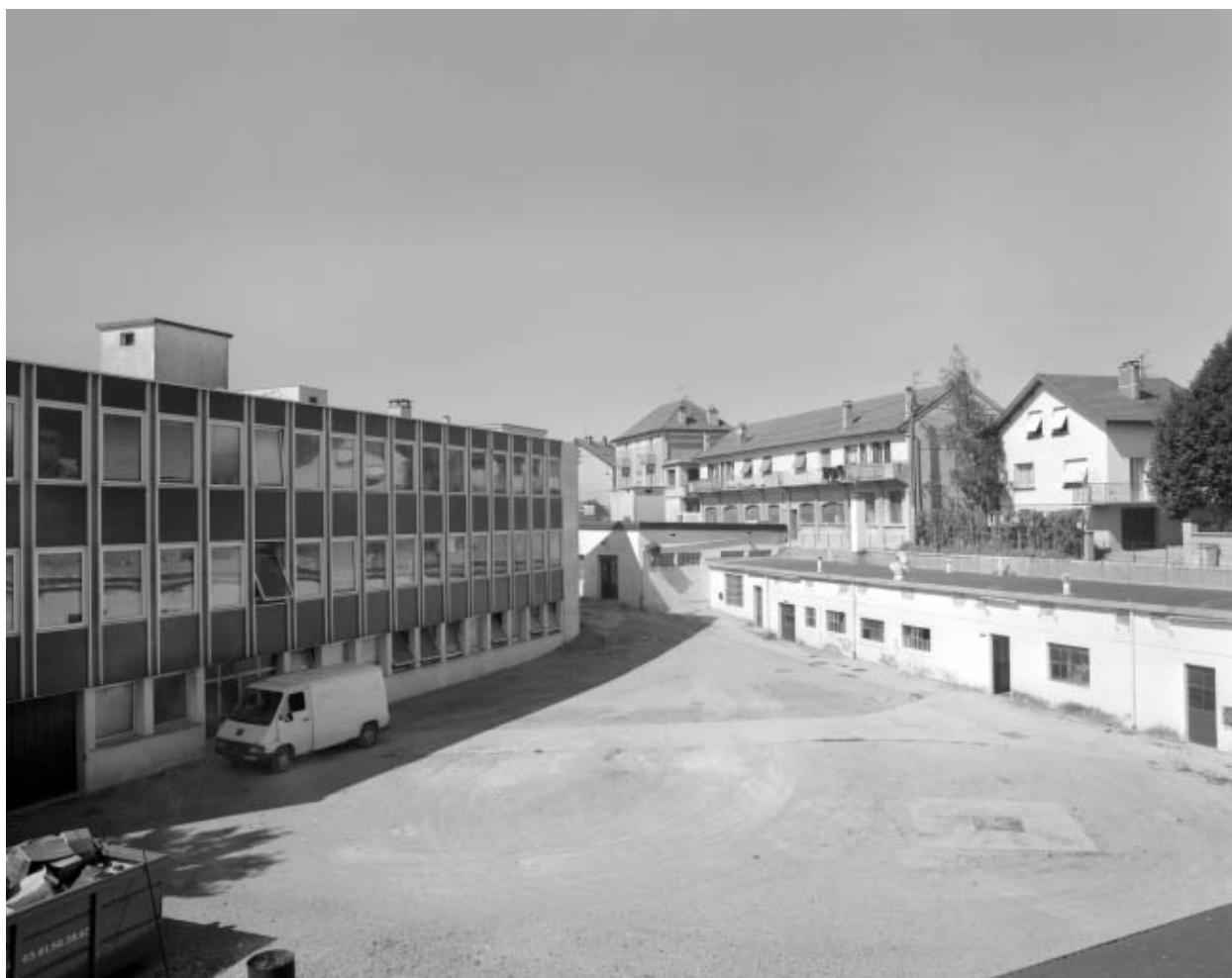
Vue plongeante sur la cour de l'usine.
