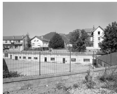
Atelier de fabrication (décapage).
