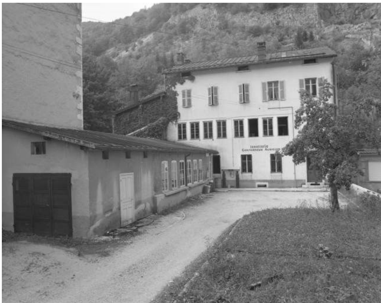
Cour et façade antérieure.
