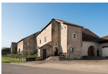
Vue de trois-quart. Phot. Jérôme Mongreville IVR43_20167001605NUC4A
