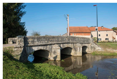
Pont enjambeant le ruisseau, la Scyotte. Phot. Jérôme Mongreville IVR43_20167001654NUC4A
