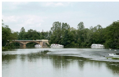
Le pont de Cuisery, vu d'aval. Phot. Jean-Luc Duthu IVR26_20107100392NUC2A
