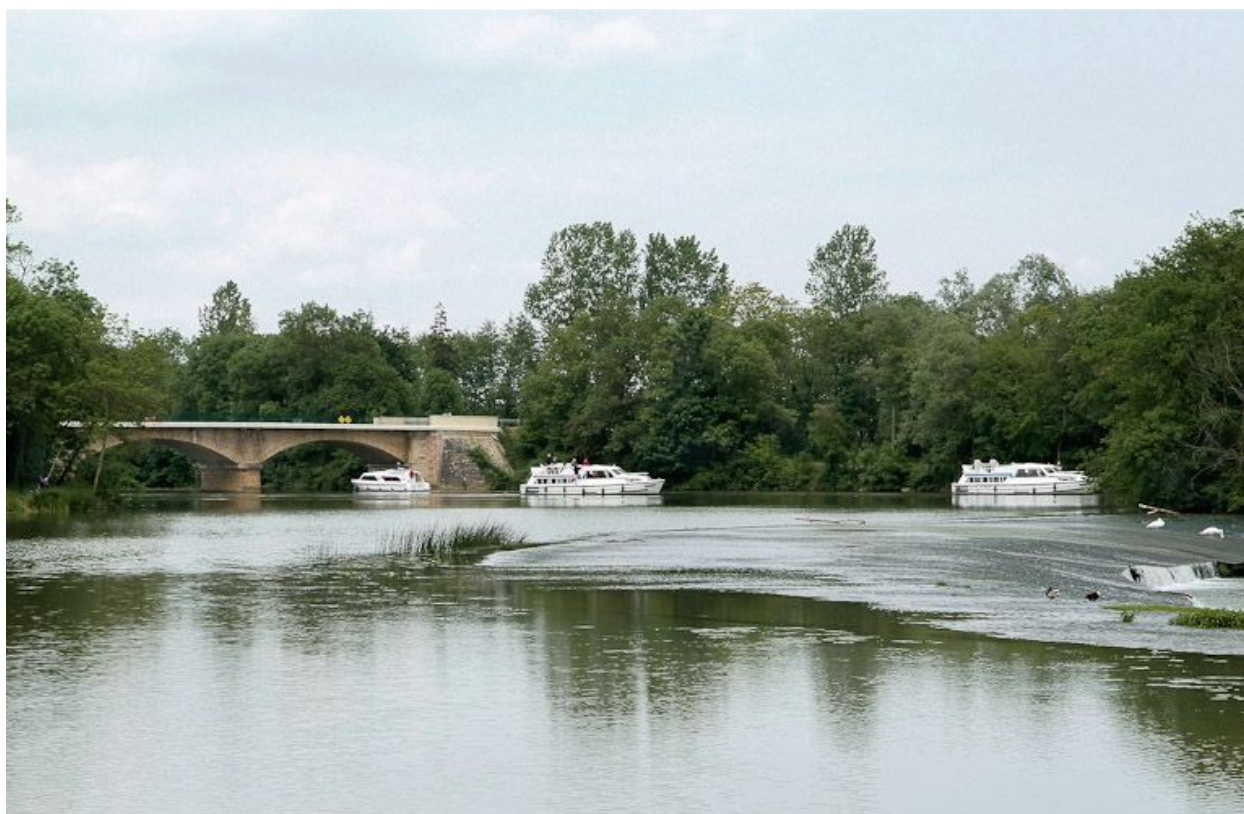
Le pont de Cuisery, vu d'aval.
