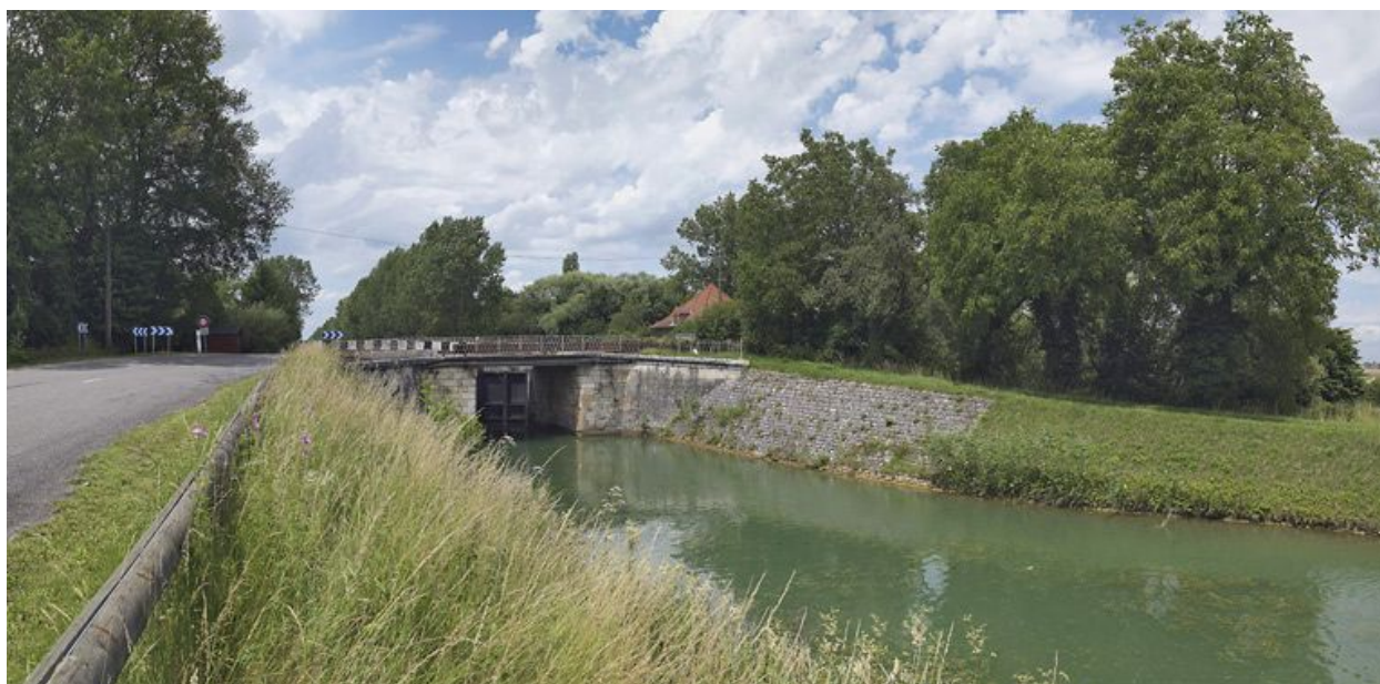
Pont vu d'aval.
