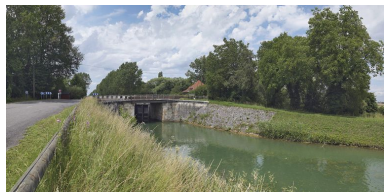
Pont vu d'aval. Phot. Thierry Kuntz IVR26_20112103130NUC4A
