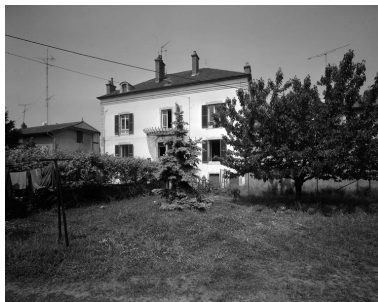
Façade postérieure. Phot. Yves Sancey IVR43_19897000327V
