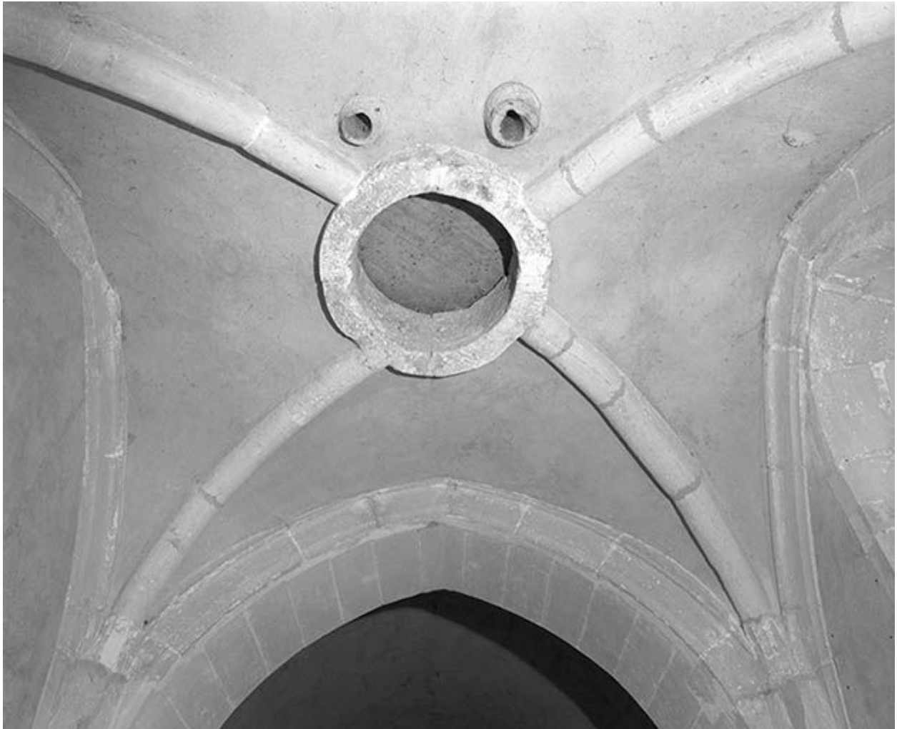
Voûte du vestibule.
