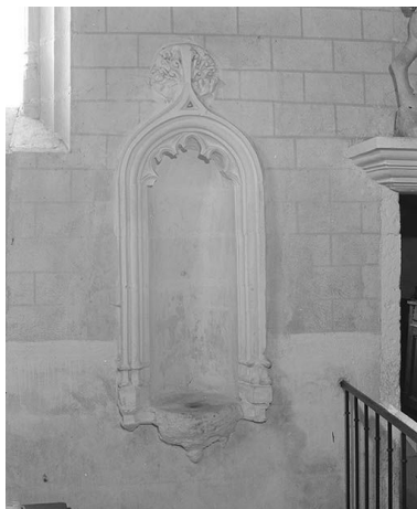
Lavabo du chœur. Phot. Jean-Luc Duthu IVR26_19945800263X
