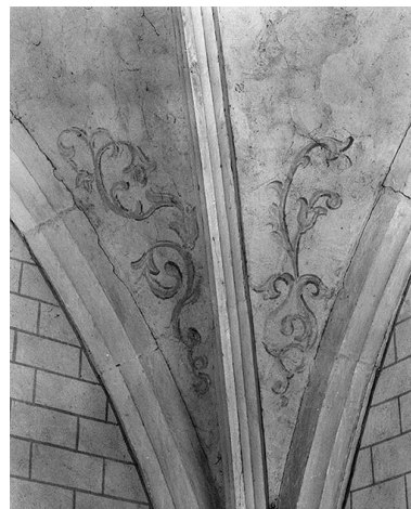
Voûte du chœur : décor peint (angle postérieur gauche). Phot. Jean-Luc Duthu IVR26_19945800260X
