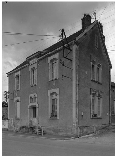
Façade principale et mur-pignon.
