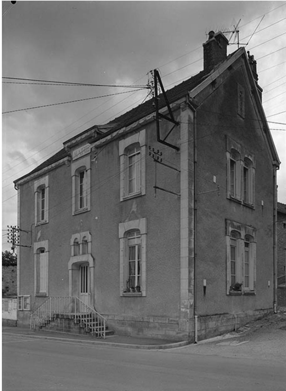
Façade principale et mur-pignon.
