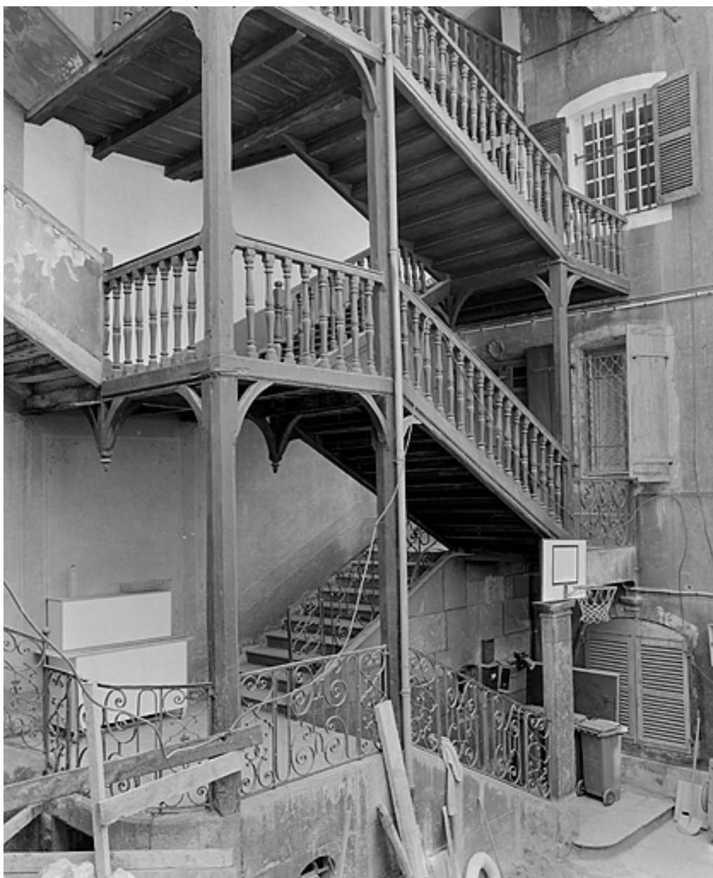
L'escalier s'ouvrant sur la cour.
