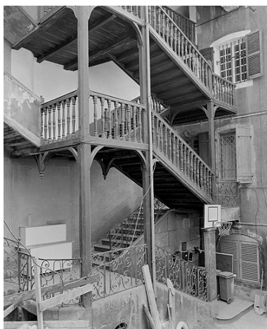
L'escalier s'ouvrant sur la cour. Phot. Yves Sancey IVR43_19853900308X
