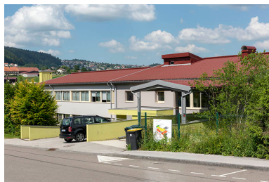
2e bâtiment, vu du sud-ouest.
