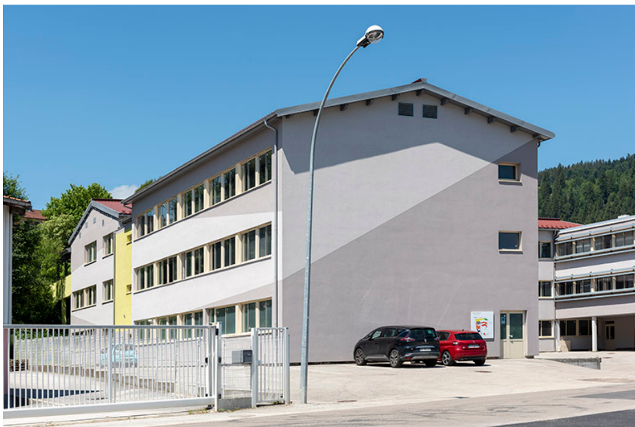
3e bâtiment, vu de l'est.
