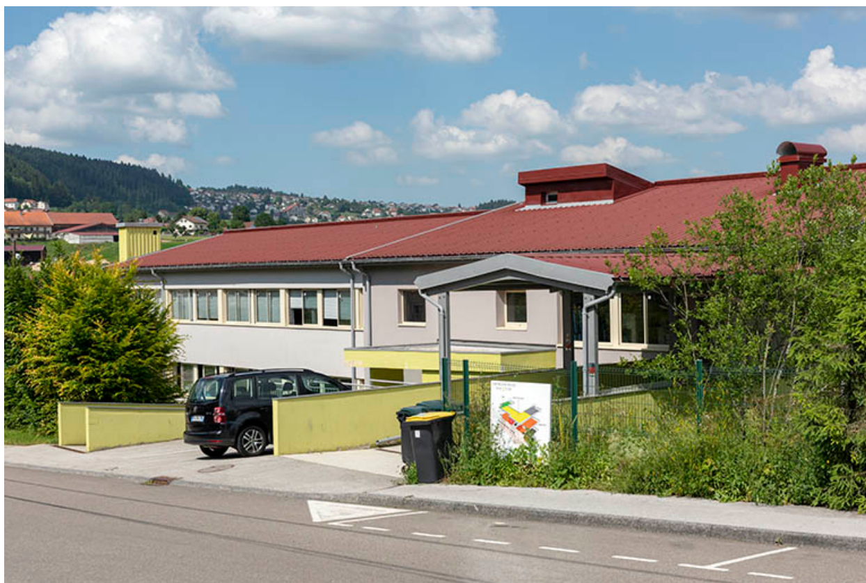
2e bâtiment, vu du sud-ouest.
