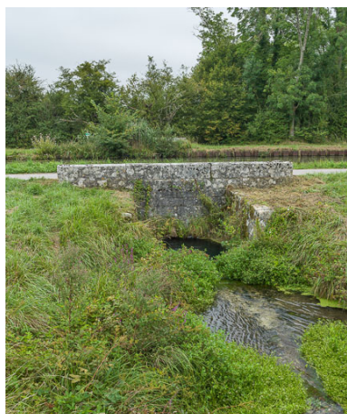
Vue de l'aqueduc.
