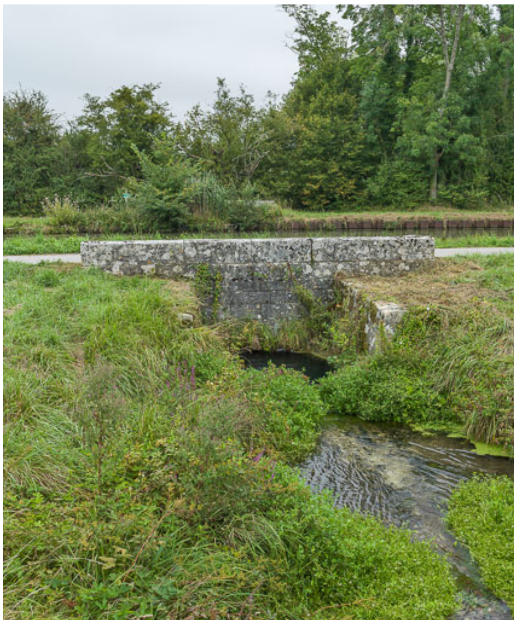
Vue de l'aqueduc.
