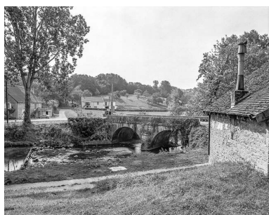
Pont sur la Sorne. Phot. Yves Sancey IVR43_19843900109X
