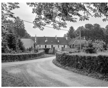
Demeure dite maison Grosmaître, située rue de l'Hospital. Phot. Yves Sancey IVR43_19843900106X
