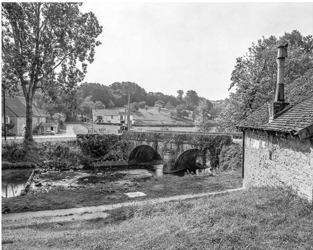
Pont sur la Sorne.
