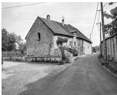
Maison de vigneron située rue de l'Hospital. Phot. Yves Sancey IVR43_19843900108X
