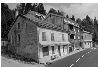
Bâtiment ayant abrité la Fraternelle. Phot. Jérôme Mongreville IVR43_19963901406X
